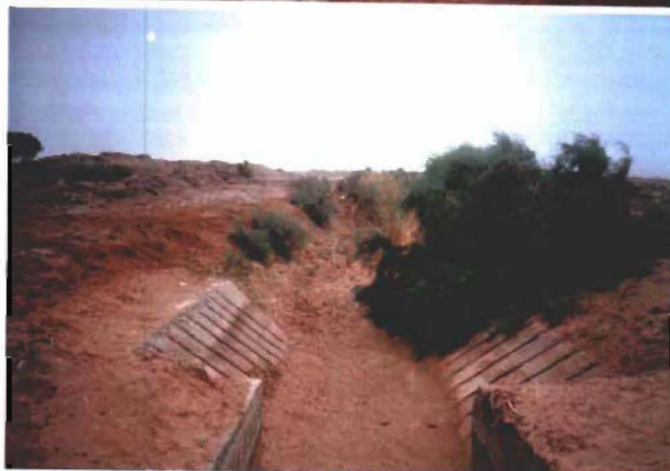
② 用水路周辺の 稲作圃場の現況
