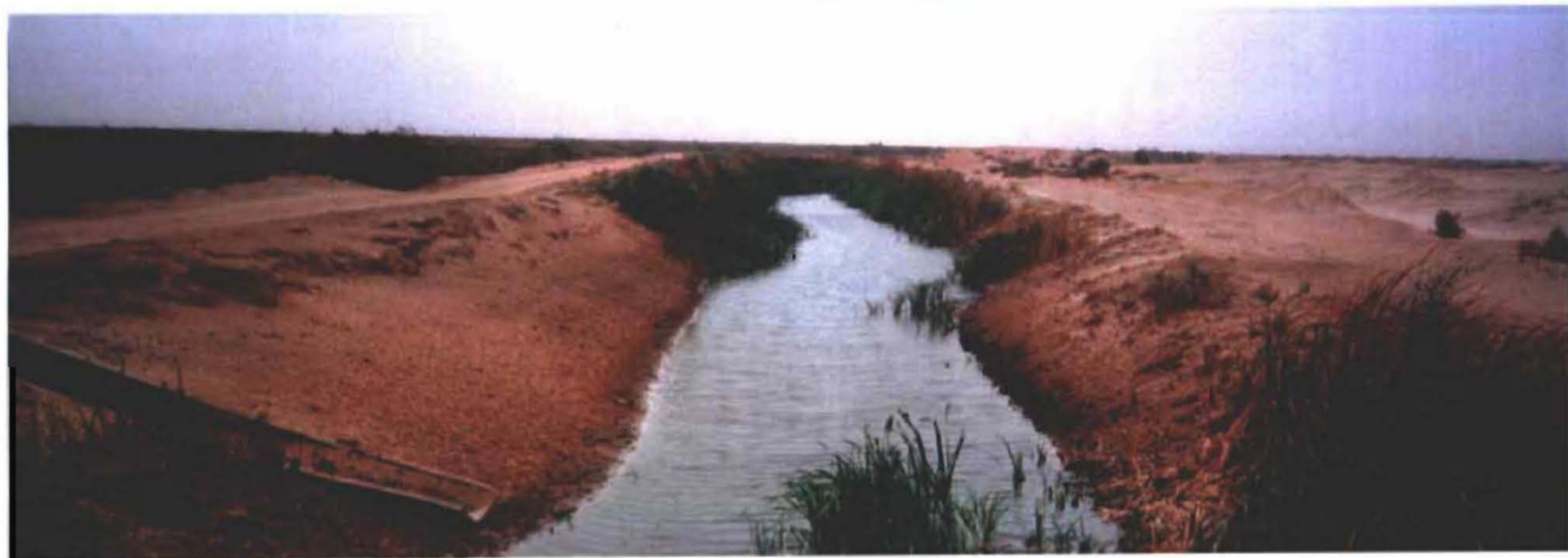
⑤ 現況の排水路
