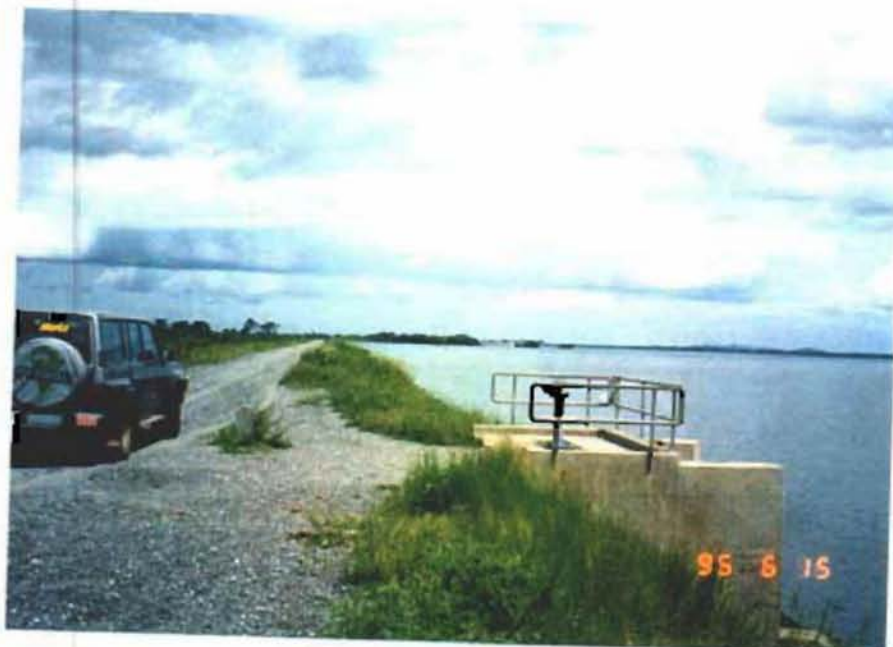
クボン左岸地区灌漑計画 クボンダムの既設取水口
