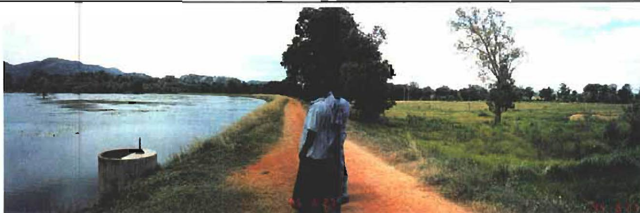
カスケード・システム内のため池(Mahanetula Tank) : 右側はため池下流域に広がる受益地
