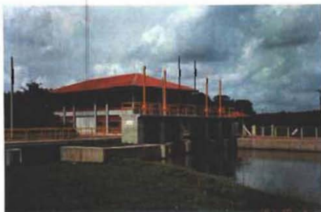
農業技術移転センター（後方）及び 頭首工かんがい施設
