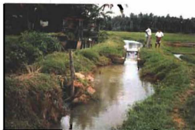
既存小規模灌漑施設(Minor Irrigation)
