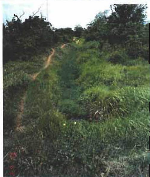
同上ため池を起点とする既存灌漑用水路
