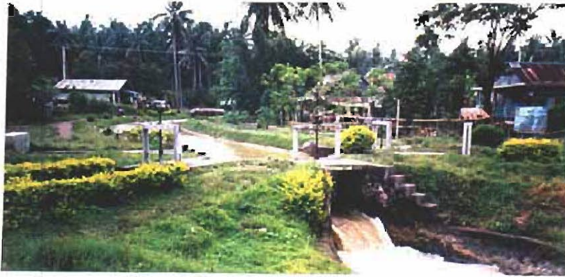
シドラップ灌漑地区 二次水路分水工
