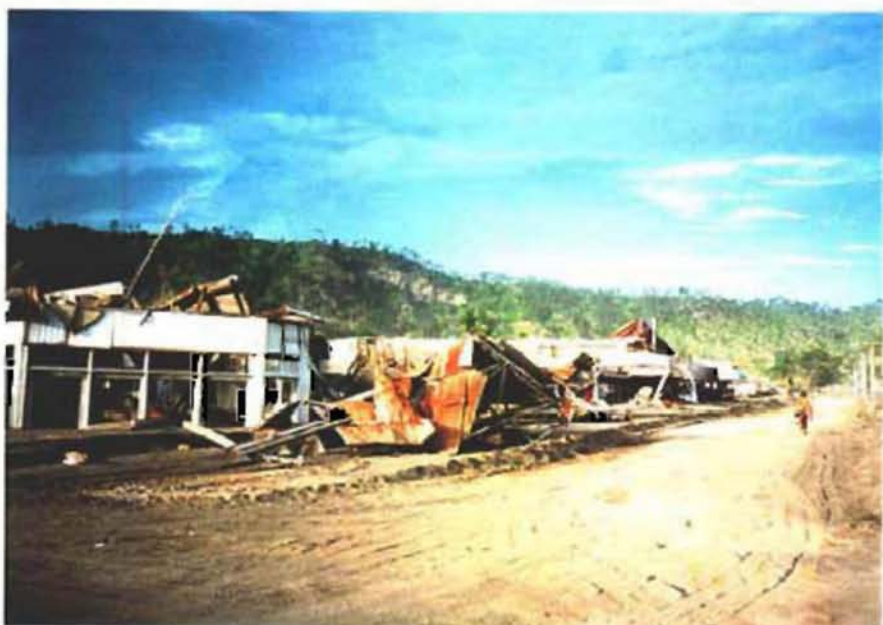
写真5：ラバウル地区 噴火により、壊滅的被害を受 けたラバウル市街。火山灰の 重量で圧壊した建物が多い。
