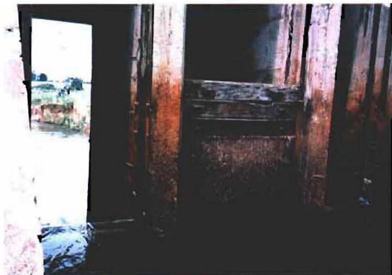
幹線水路ゲート 損傷・老朽化が進んでおり改修が必要
