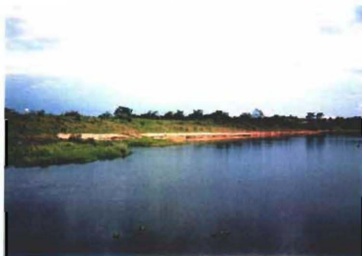
土盛の Nam Suang ダム堰堤 一部洗掘されている
