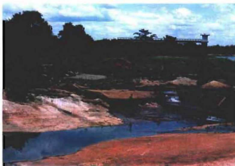
同 右岸側の洗掘が進み損傷が激しい
