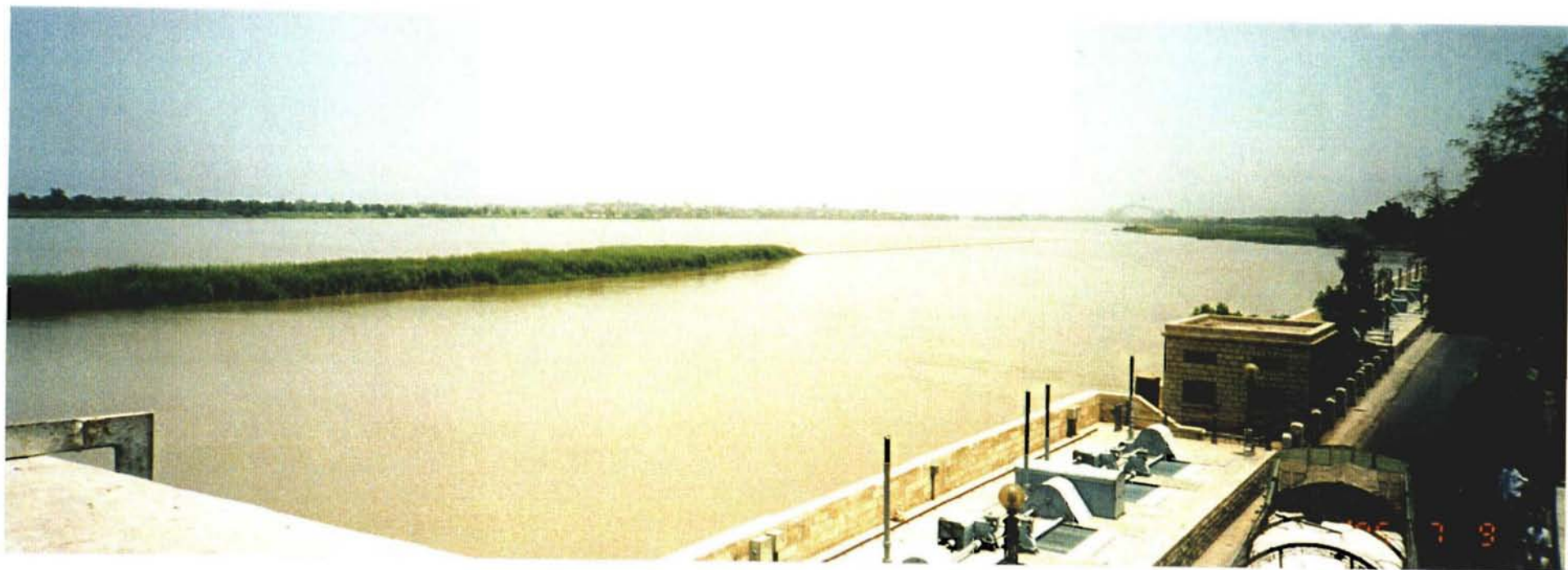
バーリッジより上流部を望む右側は左岸取水口
