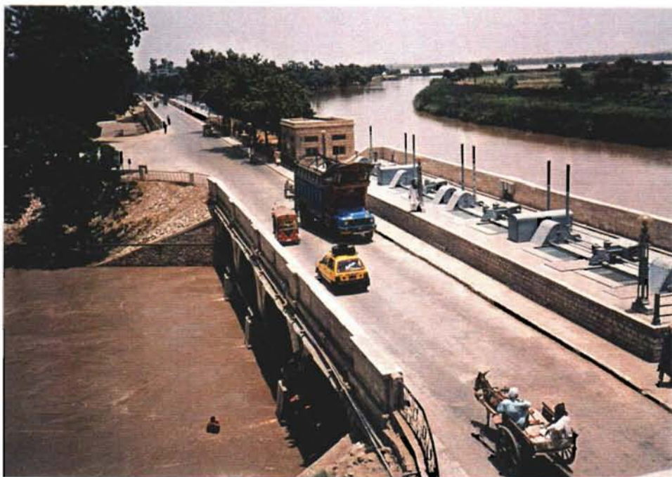
バーリッジ上流部右岸取水口
