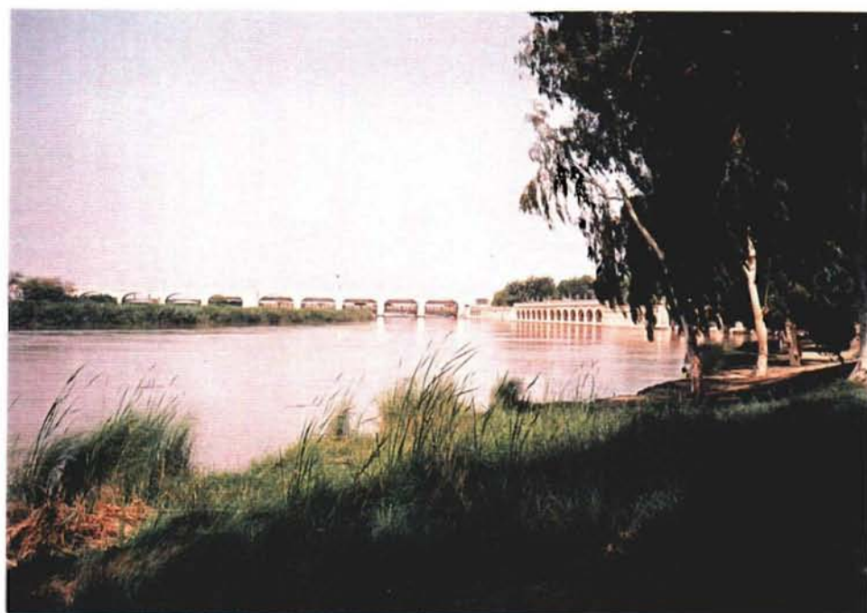
バーリッジ上流部右岸より正面に本堰、右側に取水口を望む
