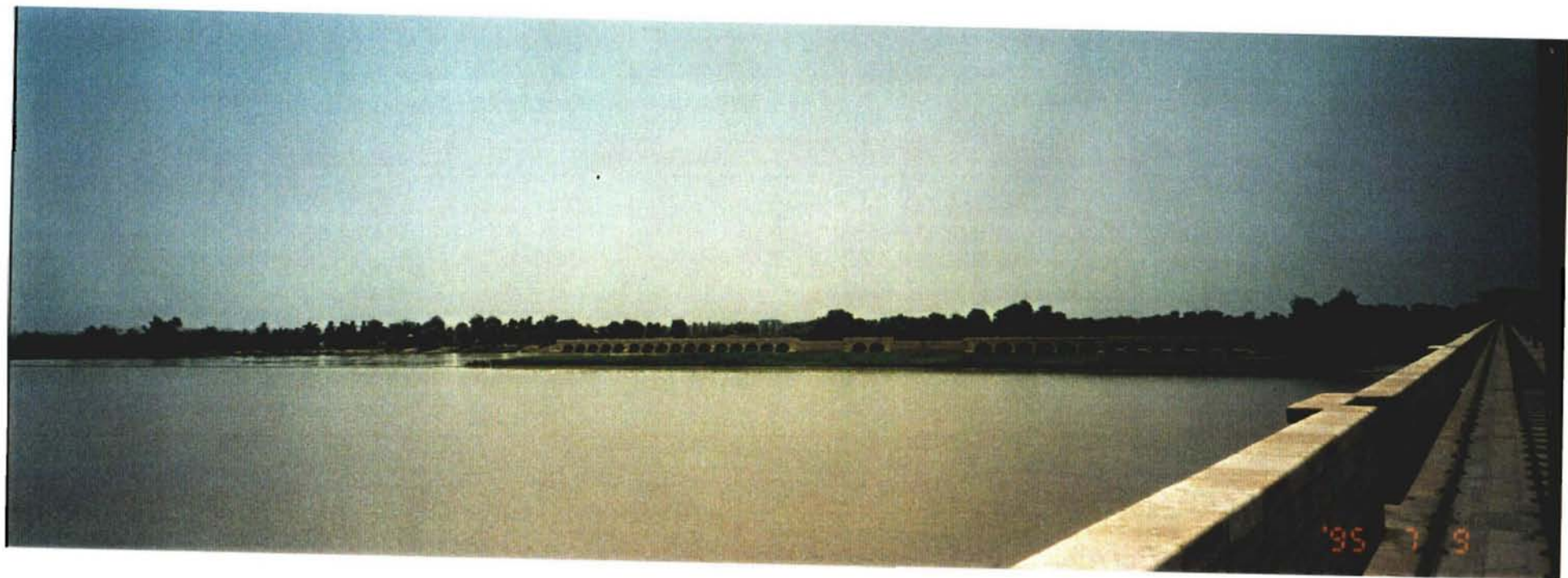
バーリッジより上流部左岸取水口
