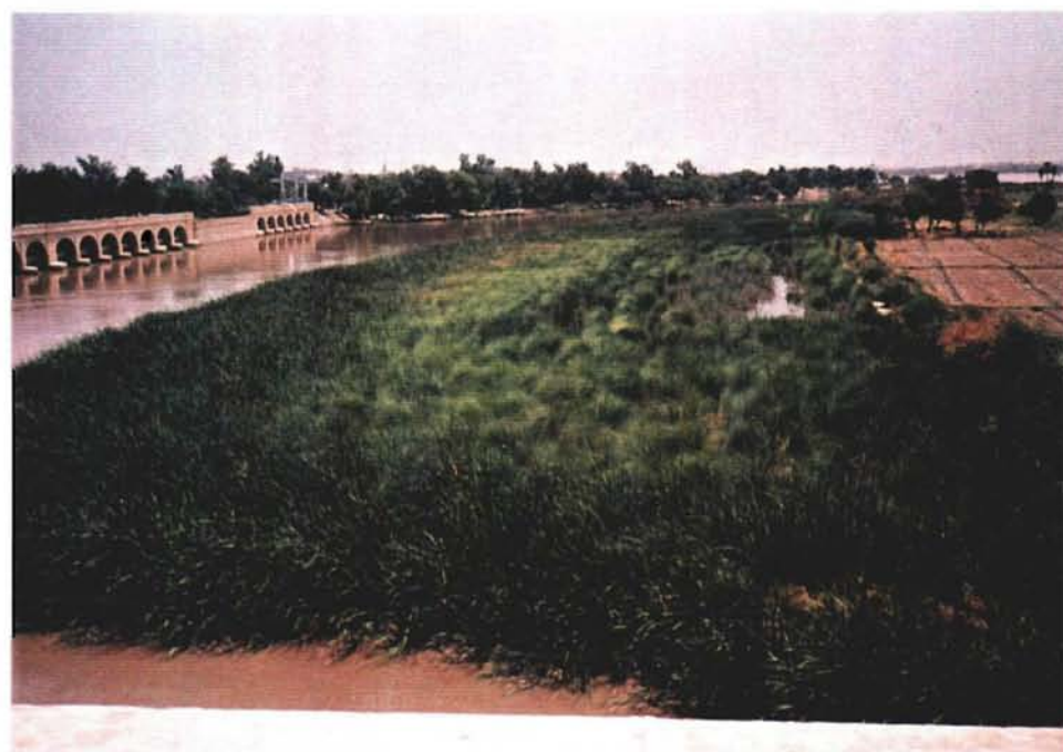
バーリッジ上流部右岸取水口および中州
