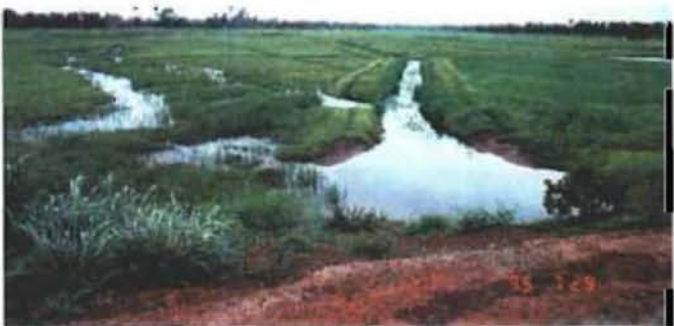
パフォン灌漑システム地域内の排水路 台湾の援助により排水路の改修が行われ、周辺のパフォンシステム水田の排水条件が改良された。
