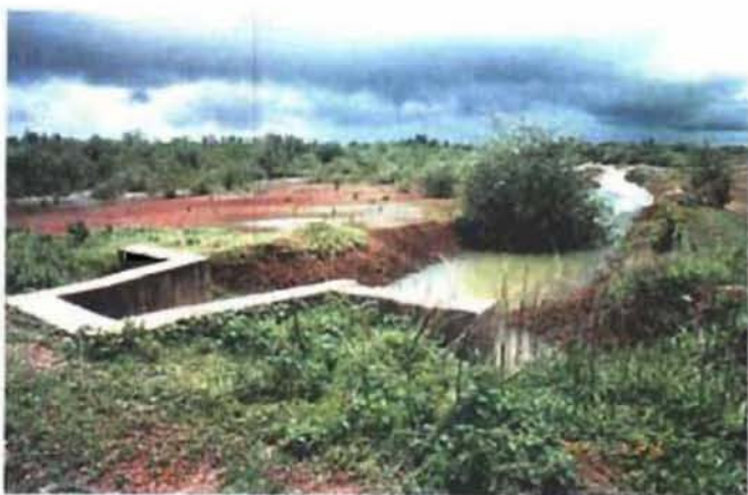
改良締切ボラーニヤシステムの排水路（地区外） 地区外は、塩類の集積が著しい。
