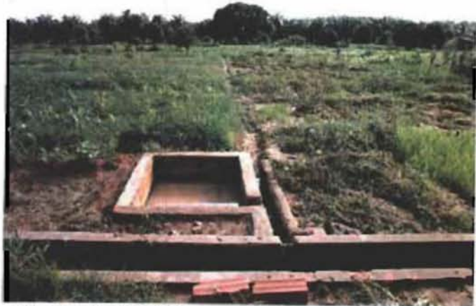
ペリメトル内の灌漑施設 水源は近所の井戸から地下水を汲み上げて利用している。 ペリメトル内の緩やかな傾斜を利用して水路が敷設され、各圃場には直接（畝間灌漑）あるいは、集水升を経て柄杓等で灌漑が行われている。
