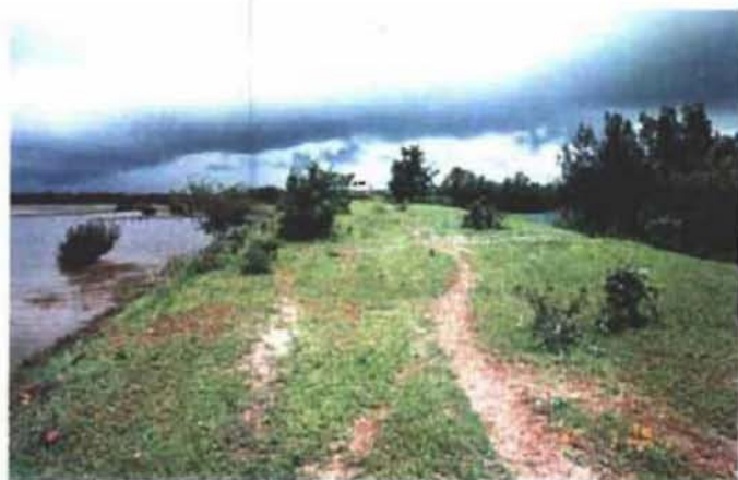
改良締切ボラーニヤシステムの締切堤 左側が地区内、右側が地区外（マングローブ林等）
