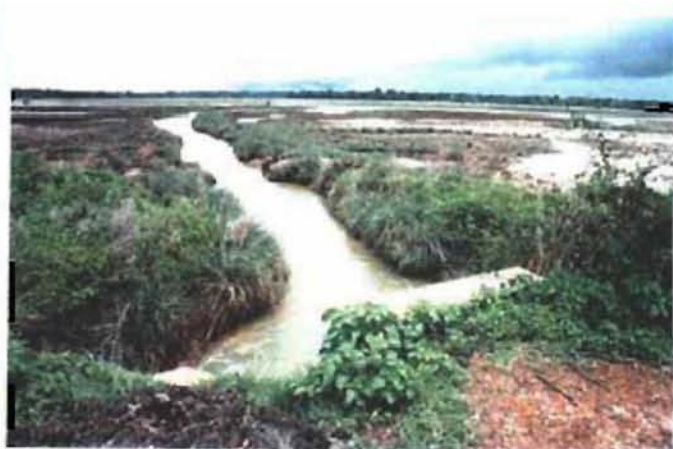
改良締切ボラーニヤシステムの排水路（地区内） ゲートが破損し、放置されているため、地区外より塩水が逆流し、地区内の一部では塩類集積が進んでいる。
