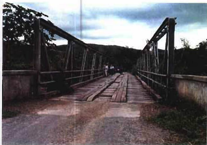
ワイ・テレ灌漑地区 (橋梁) ワイ・テレ本流に架かる橋。
