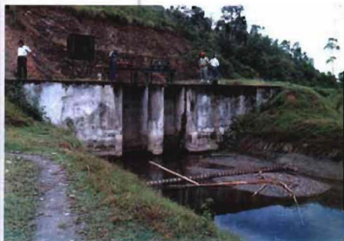
ワイ・ゲレン灌漑地区 (取水工) ワイ・ゲレンからの自然取水
