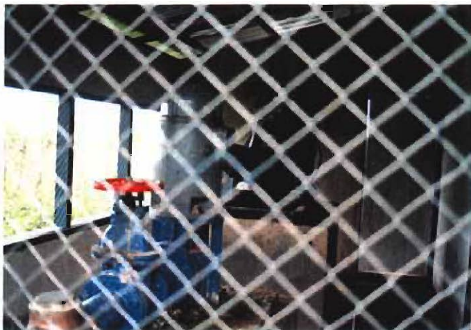
ワイ・テレ灌漑地区 (地下水施設) ポンプ・ハウスは、自噴水量 (15 liters/sec.) 以上の時期に必要となる。
