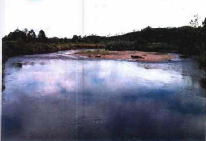
ワイ・ゲレン灌漑地区 (河川) 取水工付近は蛇行が激しいため、護岸対策も必要である。
