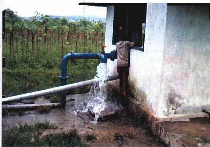
ワイ・テレ灌漑地区 (地下水施設) 井戸は深さ 80 m で、15 liters/sec の自噴が見られる。
