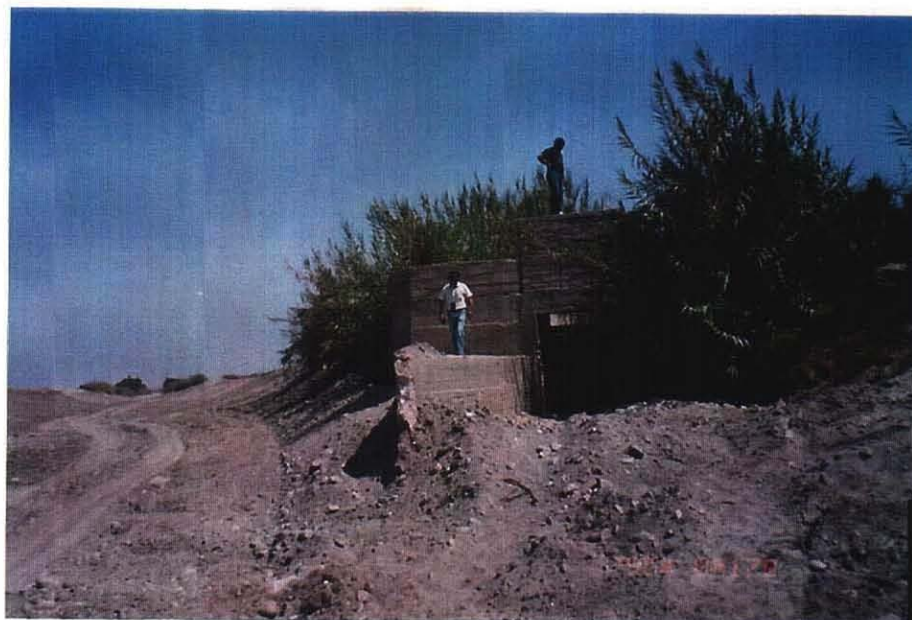
イカ川からの取水口の状況
