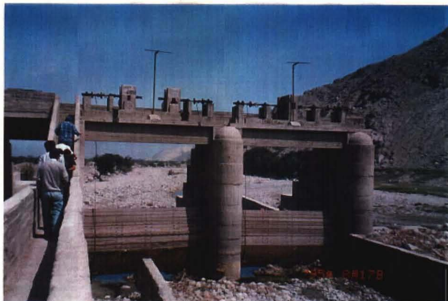
イカ川にあるアチラナ取水堰の状況
