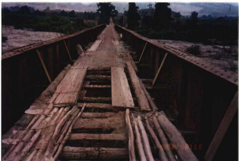
チャンカイ川橋梁（ワラル〜サンホセ）の状況
