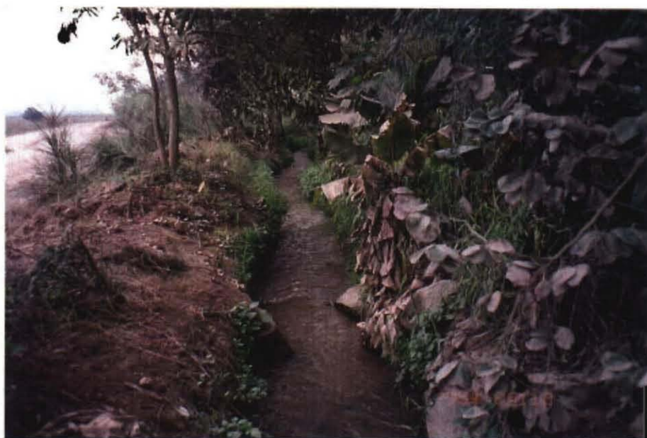
ワンド幹線水路の流況
