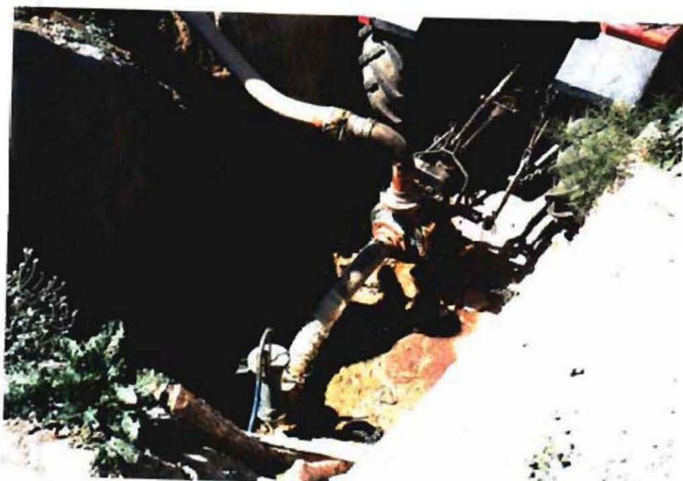
井戸には手押しポンプもついている
