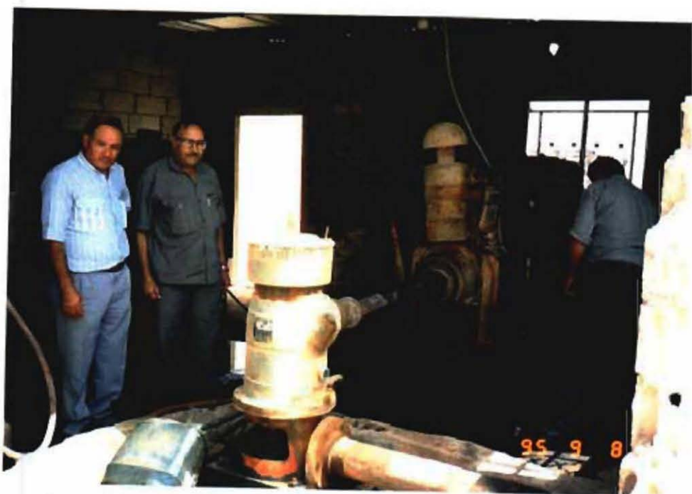
地下水揚水ポンプ
