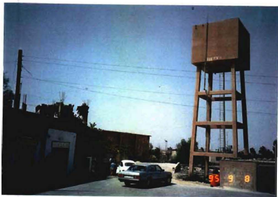
アズラックの町に配水する高架給水塔
