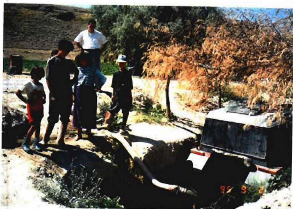
地下水位は比較的浅くポンプをトラクターに接続して揚水し、 パイプラインへ直結している
