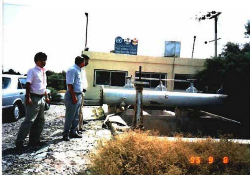
アンマンへの飲料水の送水ポンプ場
