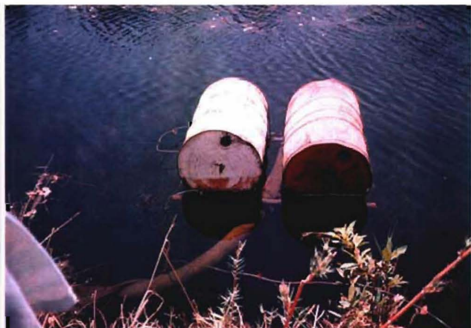
ヒュンヤニ 4 川のドラム管を利用した既設の水中ポンプ（飲料水用）。
