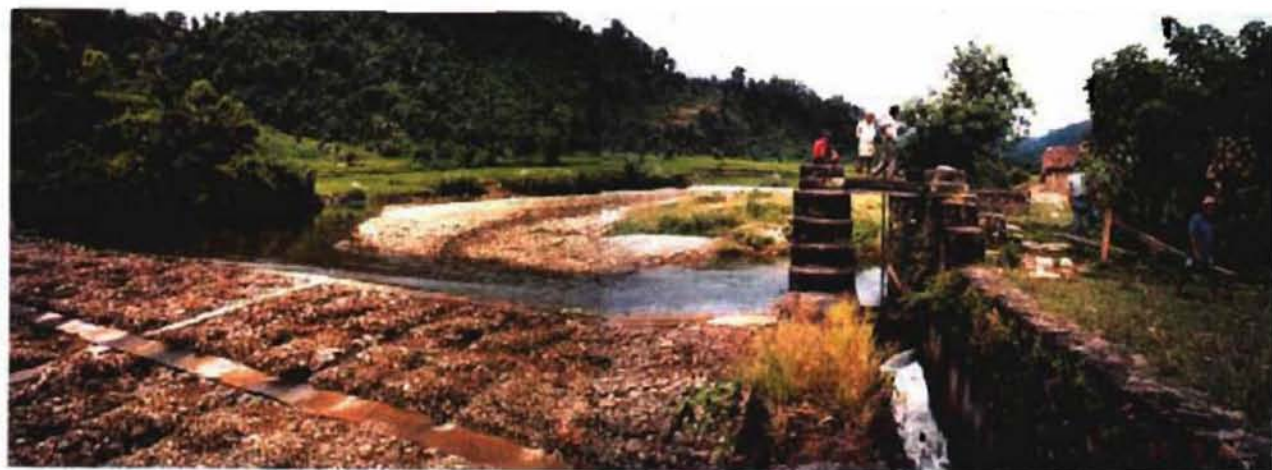
灌漑局管理下の取水堰（掘込式蛇かご工）
