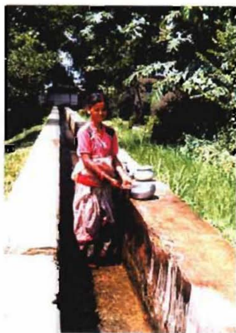
支線水路（練石積工）
