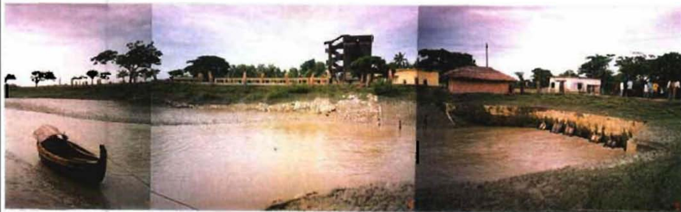
ボルダー内の排水樋門 (チッタゴン地区)
