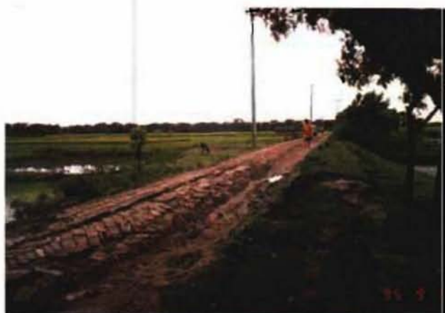
既存農村道 (チッタゴン地区)
