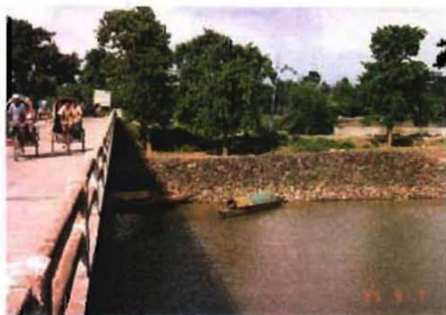
マタムフリ河護岸工
