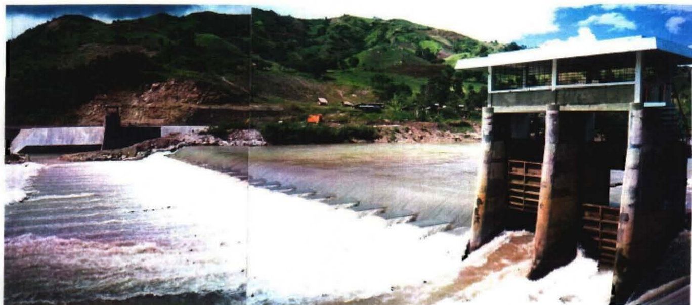
プランギ河国営灌漑組織 ISIPによるプランギ河右岸灌漑地区拡幅のための既存頭首工の改修事業
