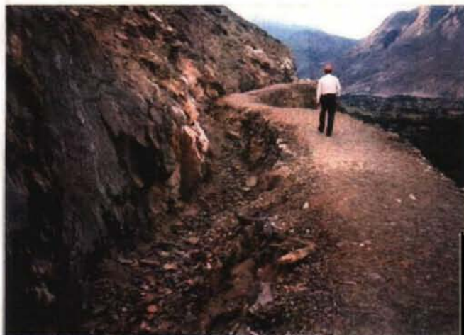
北部地域-右岸地区3 既存灌漑水路の末端部
