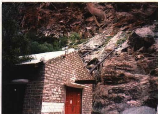
北部地域-右岸地区1 カルガーナラにある発電所（取水地点）
