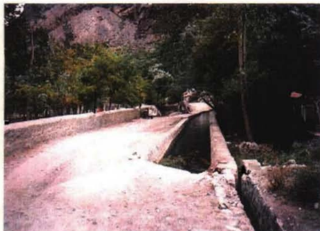
北部地域-右岸地区2 既存の灌漑水路の始点
