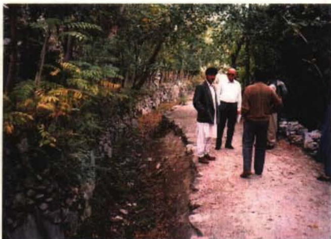
北部地域-右岸地区4 既存灌漑水路の末端部
