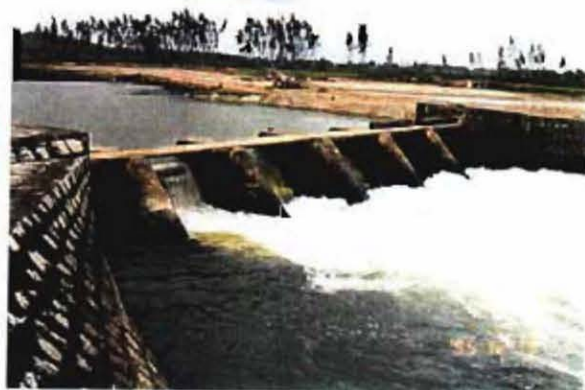
タン・アン川支流の小規模堰
