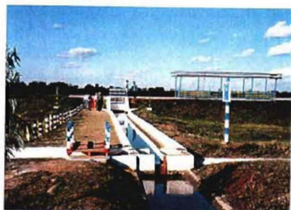
掘抜き井戸貯水池よりの水路
