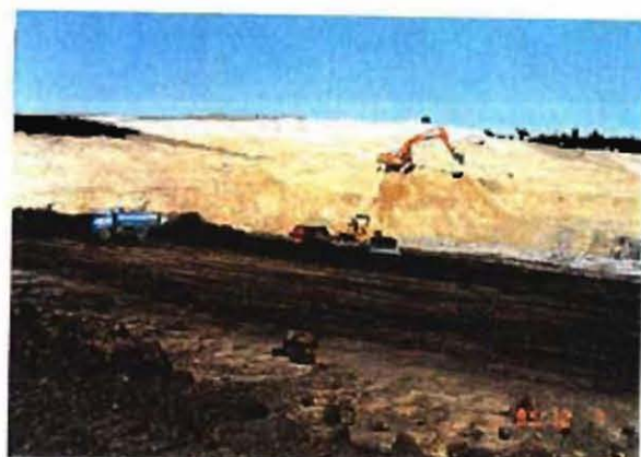
建設中のタマクダム
