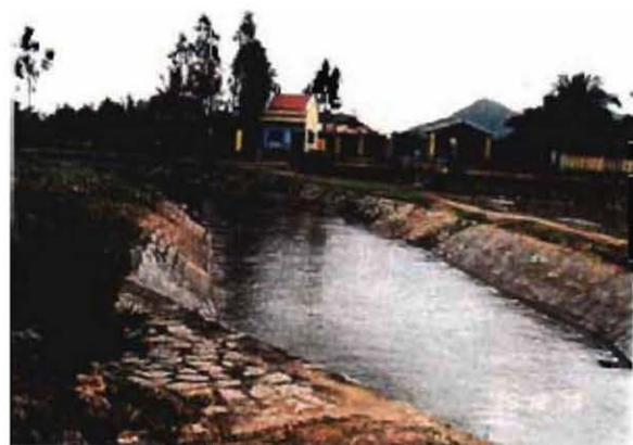
タン・ホア堰からの幹線用水路
