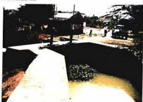
ドン・モイ堰からの取り入れ水路
