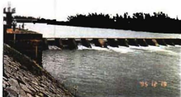
タン・ホア堰
