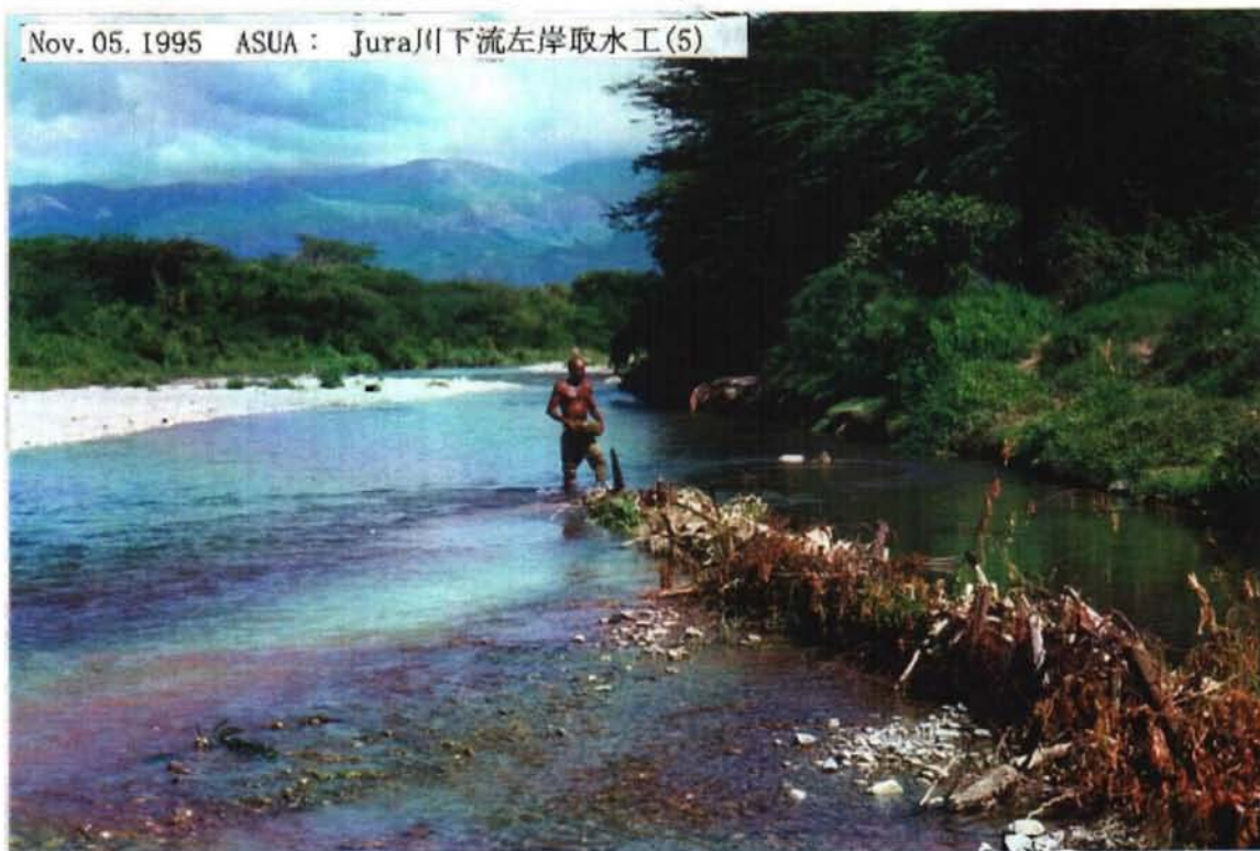
ー・補修中の取り入れ工・ー
