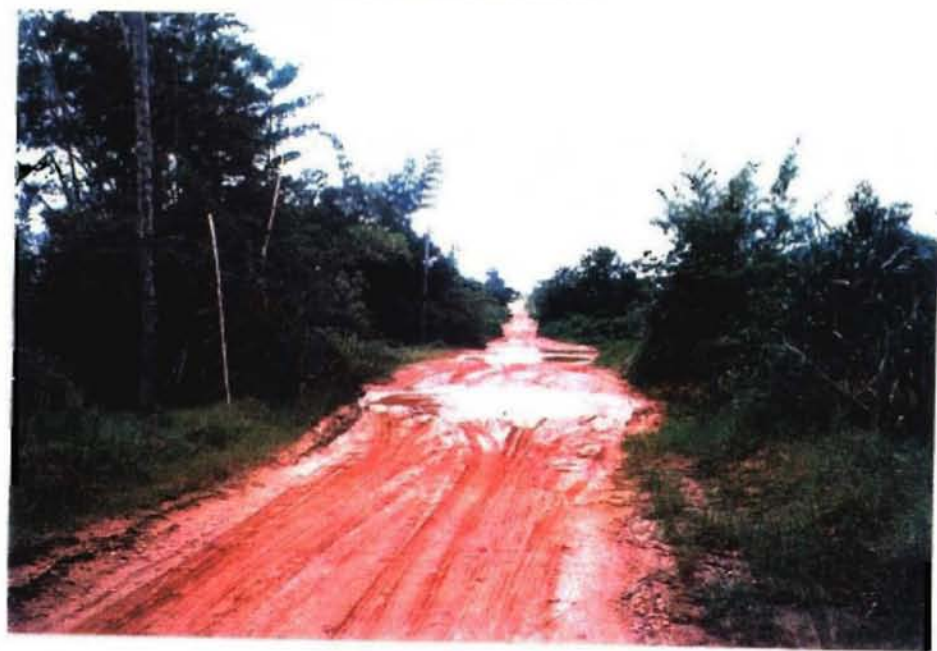
▲ 灌漑施設が未整備のため生育の遅れて立ち枯れするブドウ園 ▼ 降雨により路面が浸食された連絡道路
