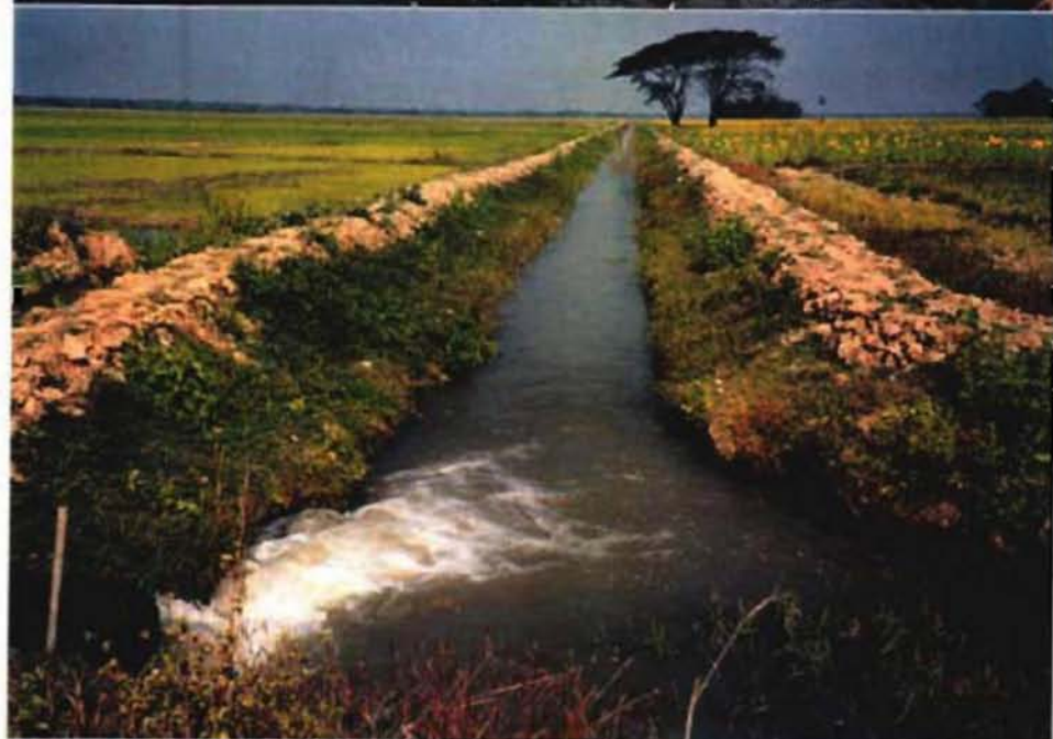
ポンプ取水による かんがい風景
