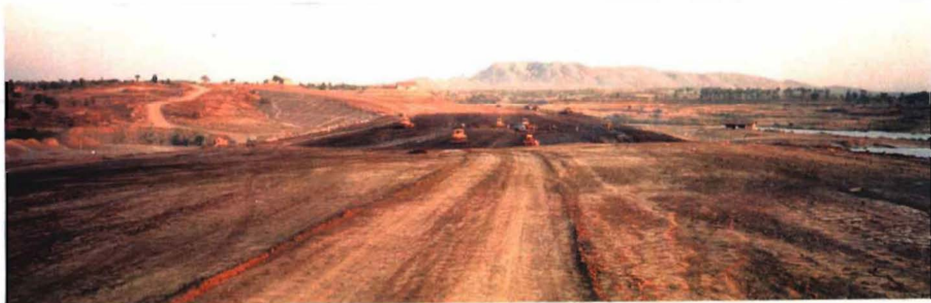
施工中の Sindawa(Thametku) Dam
