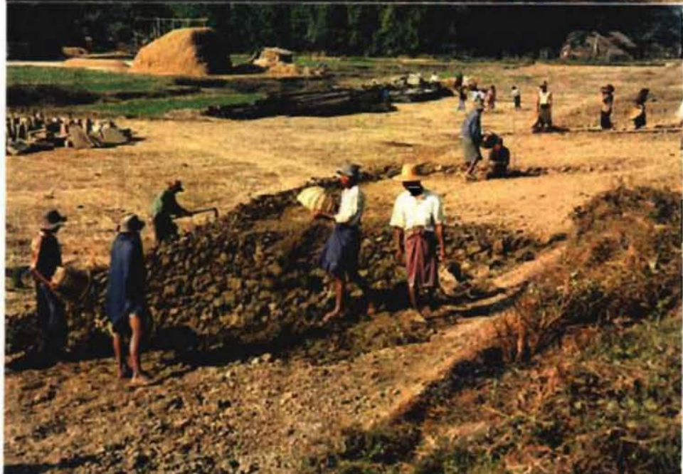
人力による ポルダーダイク 補修光景
