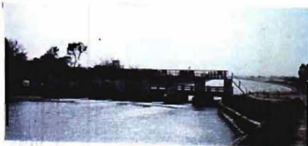
5. 揚水灌漑取水用水位調整ゲート
