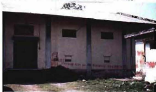
5.NFCネパールガンジ食糧倉庫(100トン、50トン、バネケ県)
