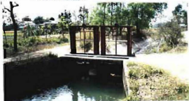
8.フェーズ-2地区幹線水路への取水工
