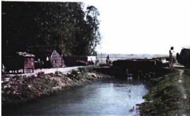
15. 揚水灌漑二次水路(D-1)
