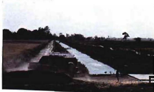
16. 揚水灌漑二次水路(D-2)
