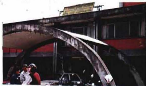
3.NFCブトワール食糧倉庫(100トン、ルパンデヒ県)
