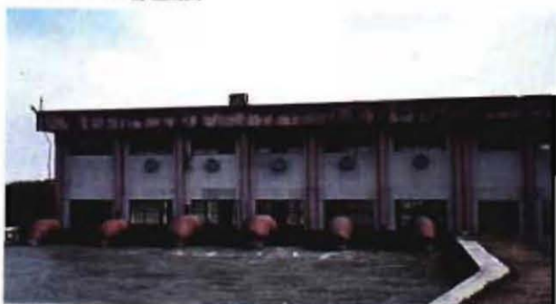
10. 第一ポンプ場吐出口
