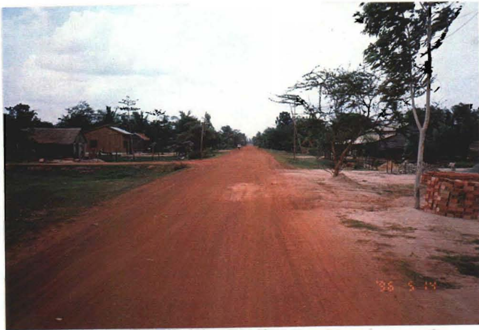
日本政府支援による“三角プロジェクト”で改修した農村道路。 コンボンスプー県庁前から国道3号線のトラムカナル村までの42.1 km。
