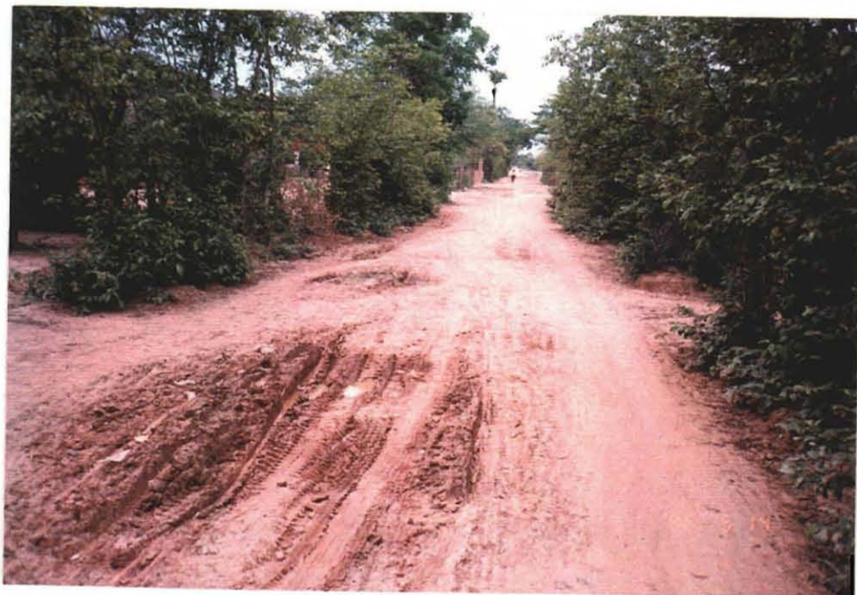
コンボンスプー県オドン郡と国道4号線を結ぶ農村道路 雨期の走行は大変困難となる。
