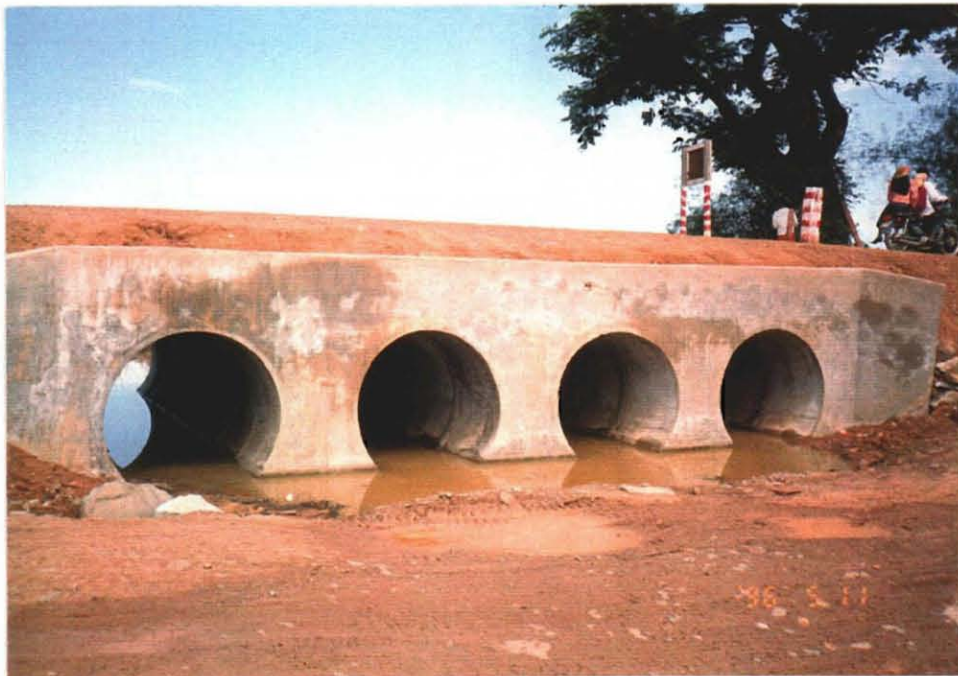
同上、道路横断排水管工 コンボンスプー県コンピセイ郡。
