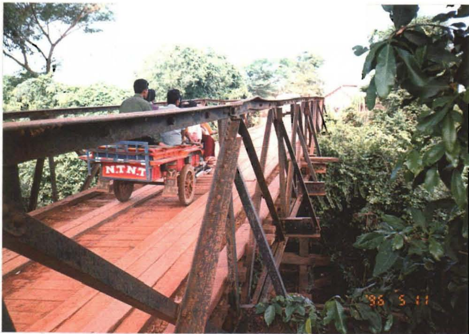
1960年代に建設されたトラス橋、橋台部は崩壊している。 コンボンスプー県コンピセイ郡。
