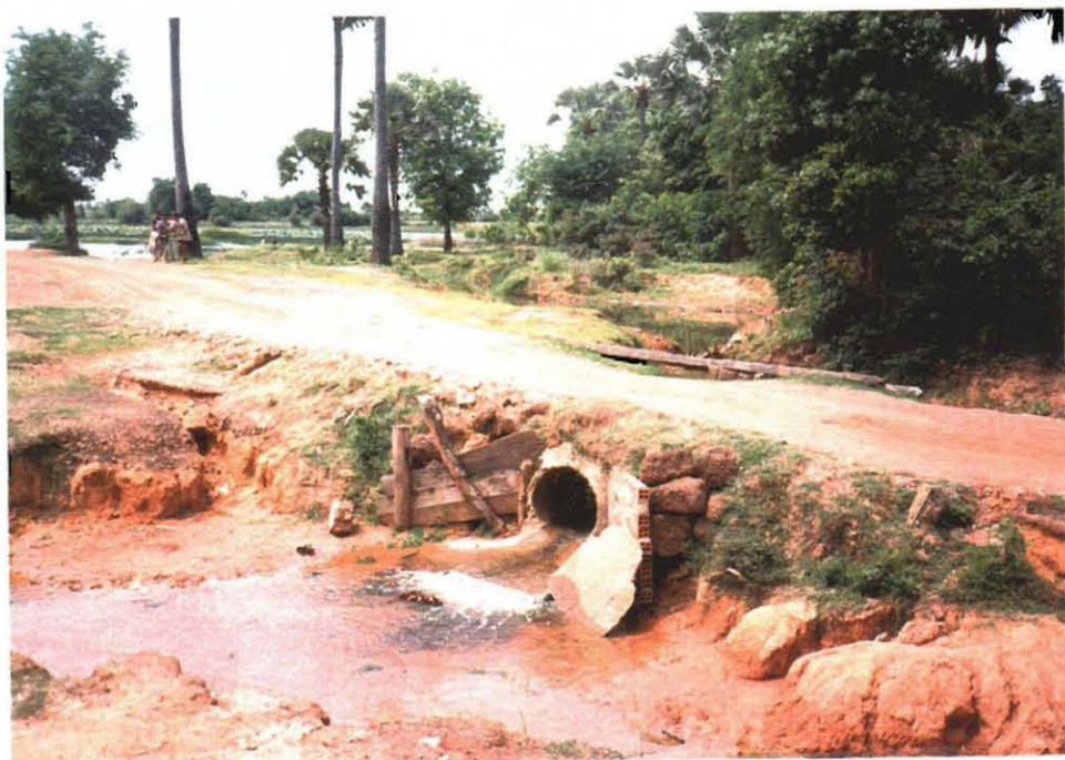
農村道路改修（路盤工・排水路工）が必要である、 コンボンスプー県プレイカリア村付近。
