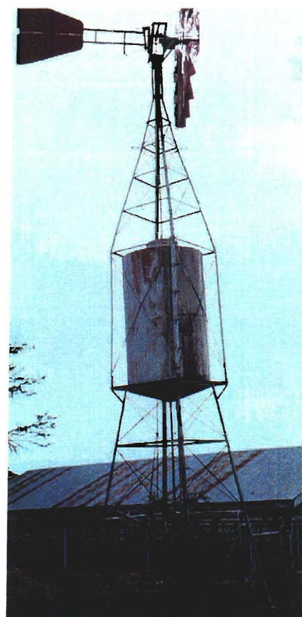
風力を利用した地下水揚水施設
