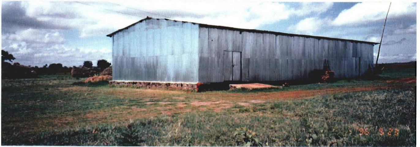
KUNZILA 原種農場種子倉庫.....雨期の雨漏りが懸念される
