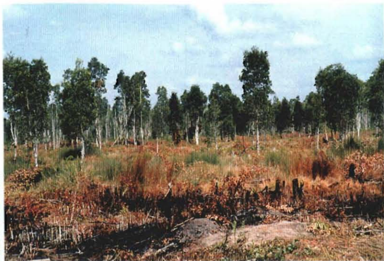
パリンカウ移住者定着地の建設現場と ガラム林 (ユーカリ科)
