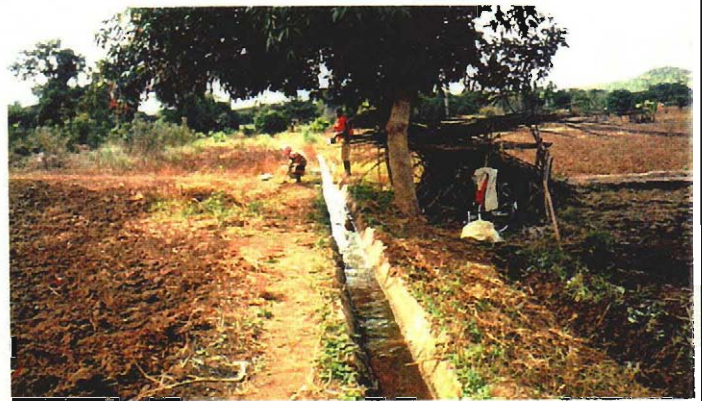
Nkandabwe地区の用水路
