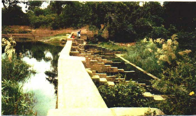
Nkandabwe地区の取水堰
