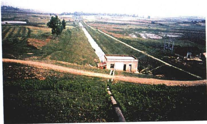
ダムからの用水路とポンプ場
