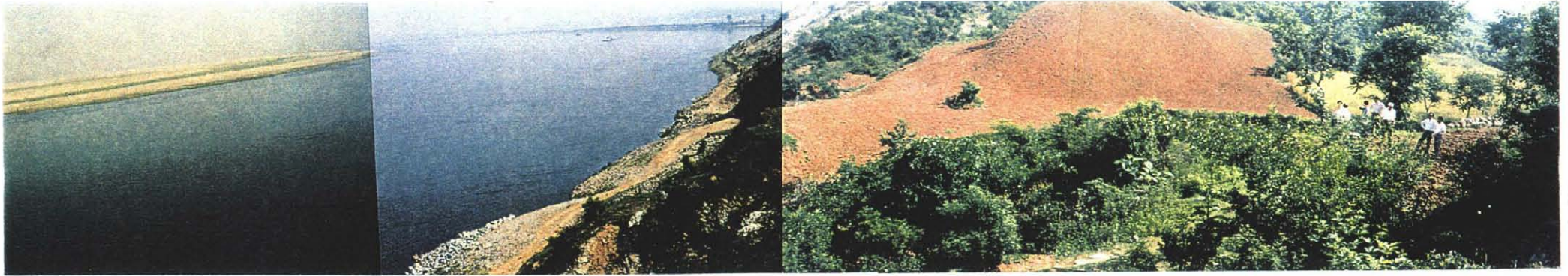
漢江と長山一級ポンプ場建設予定地 ( Q=30\text{m}^3/\text{s} , H=50\text{m} 漢江左岸下流から上流望む)
