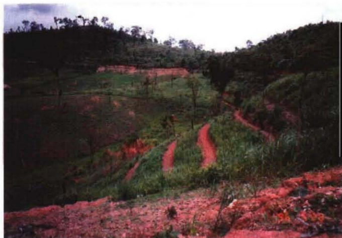
テラス工を施し、陸稲の栽培を行っている
