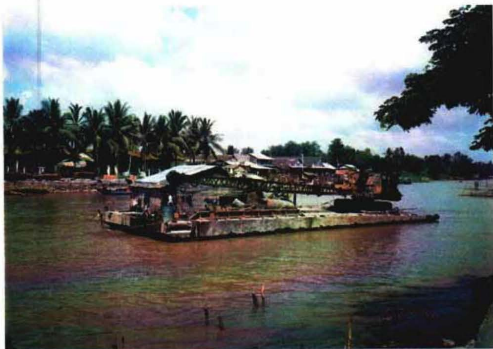
グエン・ヴァン・テイエップ第1次水路の始点から30kmのミイ・アン付近における水路浚渫船(5月28日)
