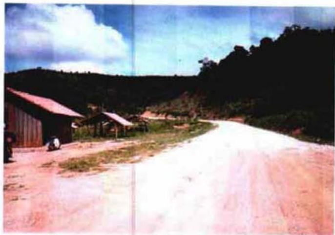
幹線道路および建設中の住居
