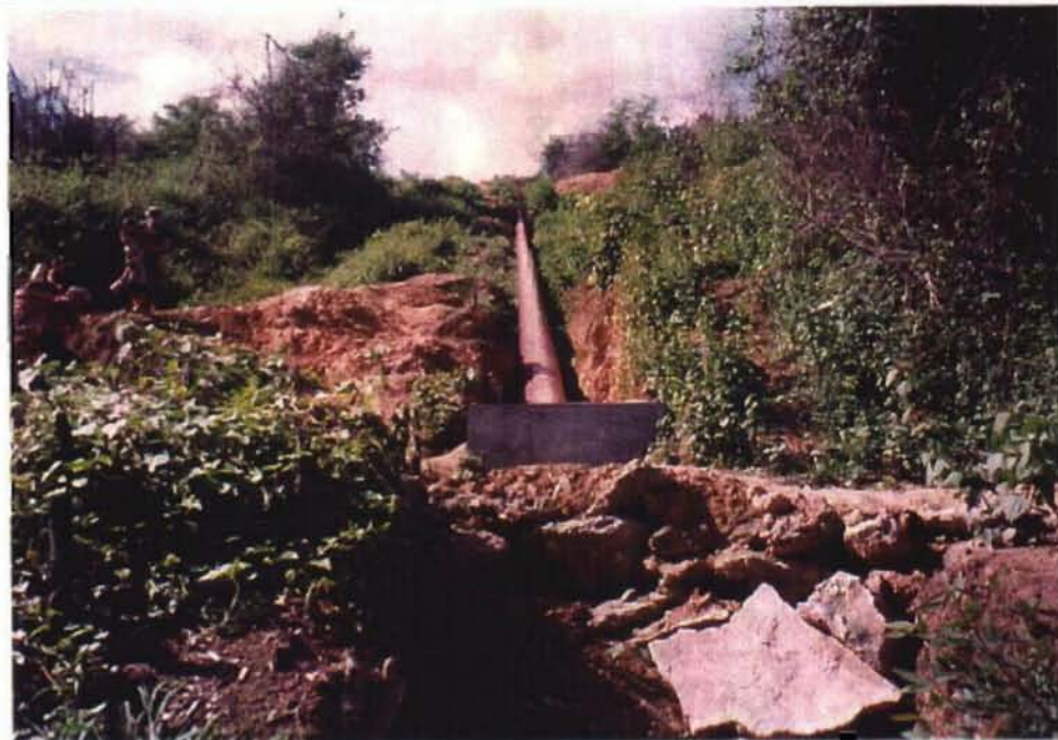
小水力発電用の導水パイプ
