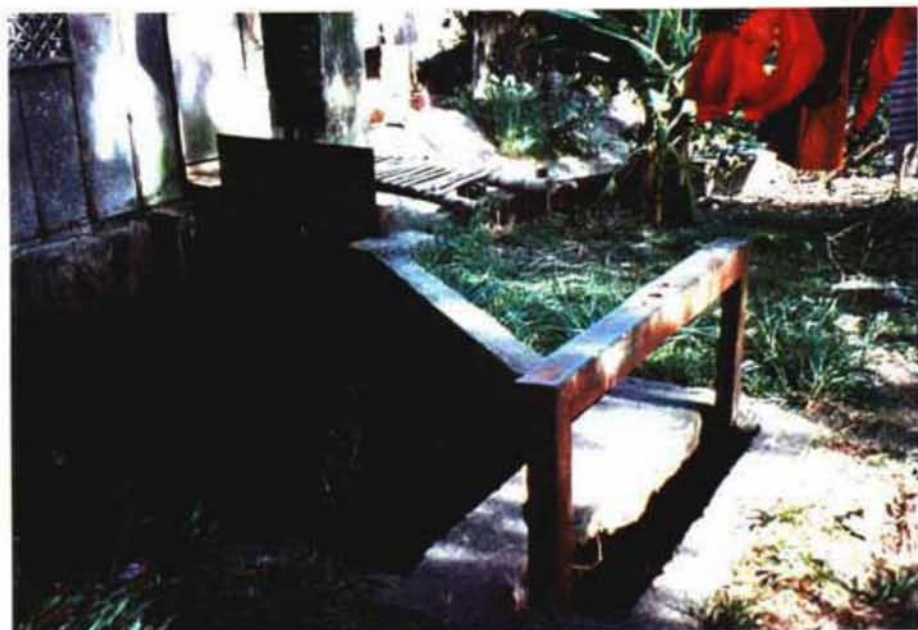
チェックゲート（ラテラル水路Jへの分岐部）
