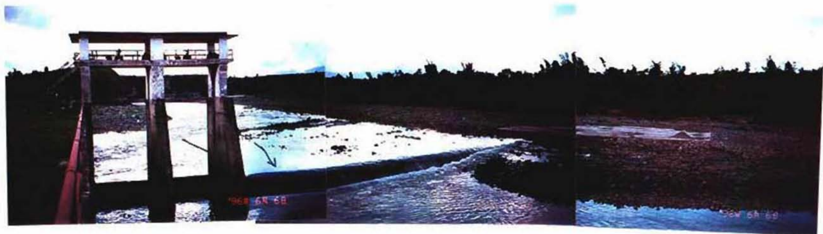
バゴ川取水堰（ゲート操作不能）
