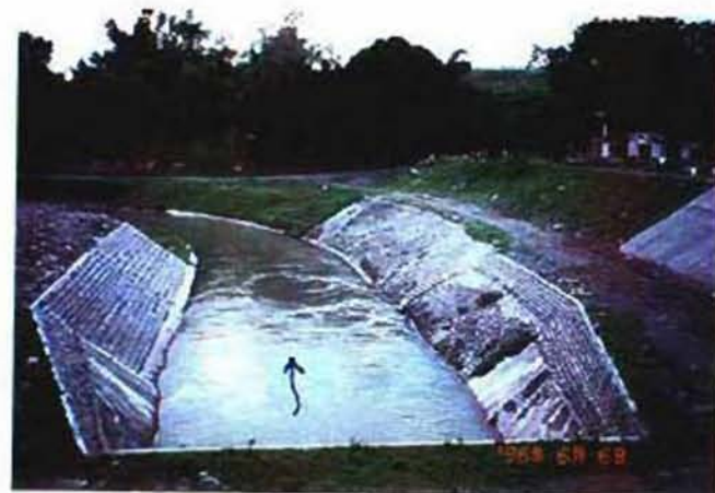
バゴ川取水堰取水口出口（主水路流入部）
