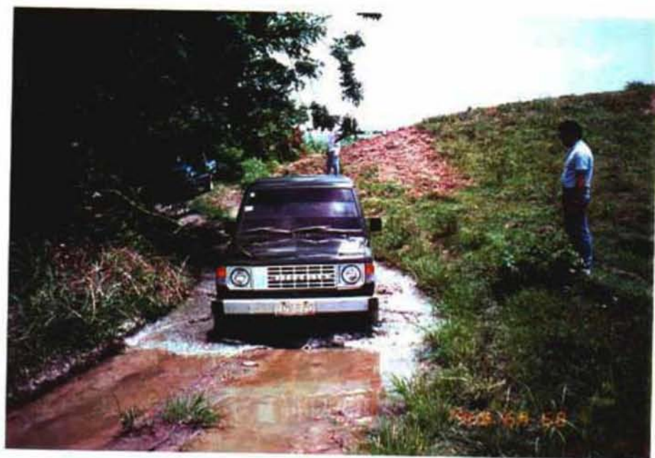
BRIS地区内サービス道路の状況
