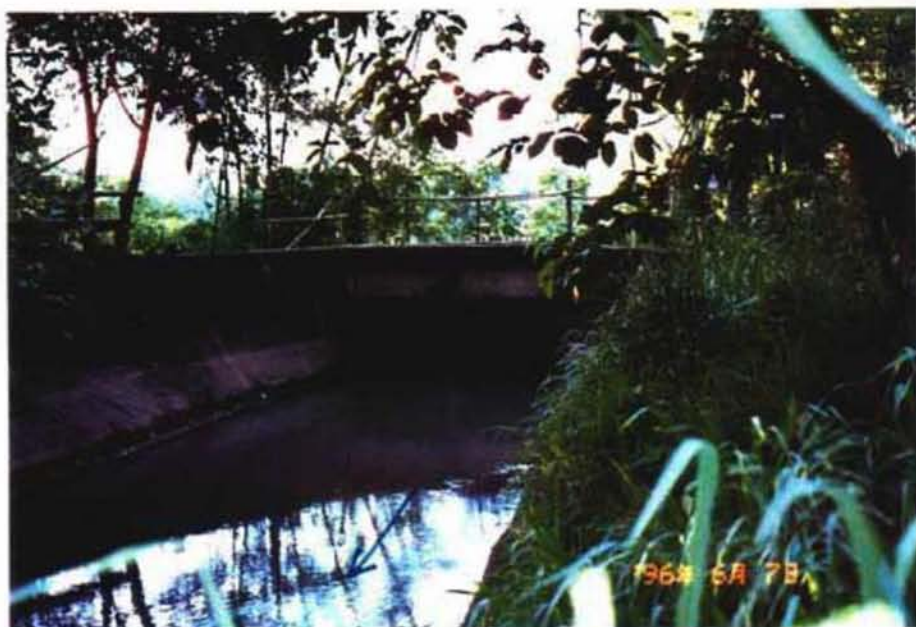
サイフォン部出口（左側閉塞している）
