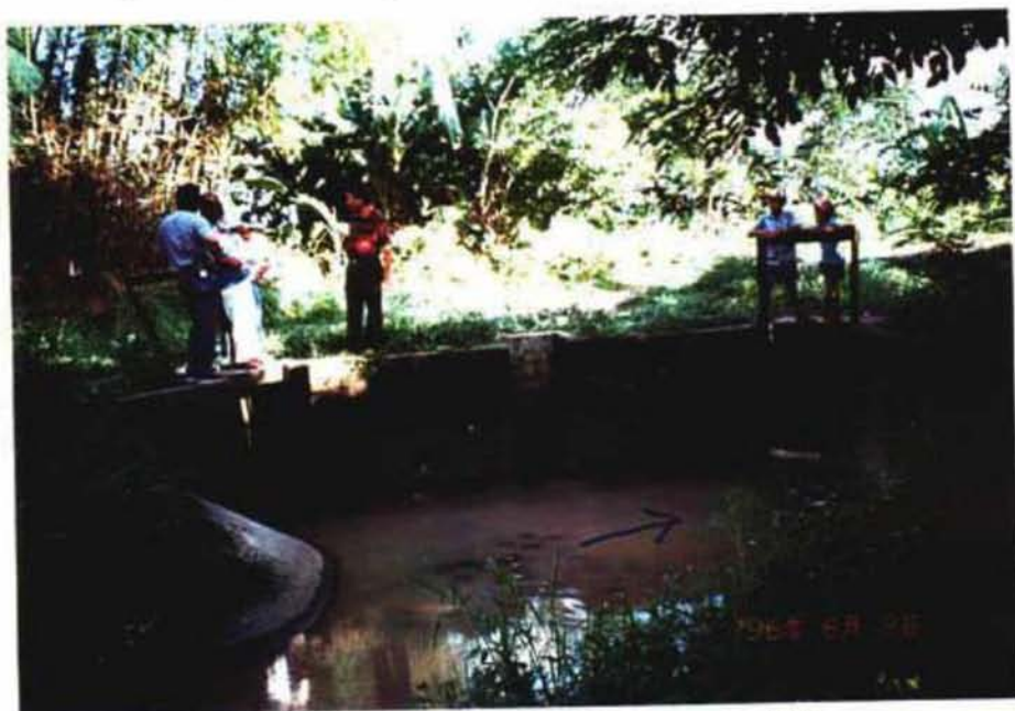
チェックゲート（ラテラル水路Kへの分岐部）
