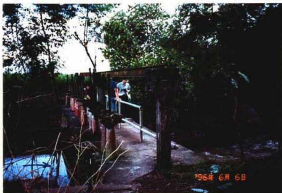
チェックゲート（ラテラル水路Aへの分岐部）
