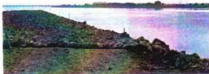
Guddu Barrage 上流より右岸・ポンプ場予定地(右端)
