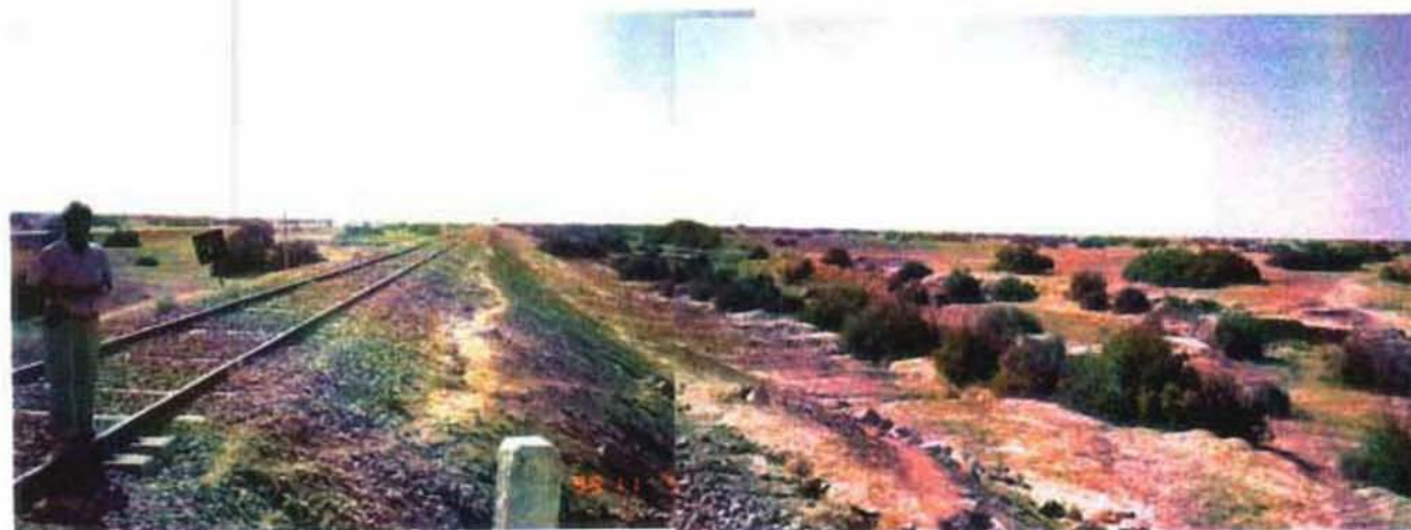
ポンプ送水路(開水路)中間部の鉄道及びインダスハイウェイ横断部の全景
