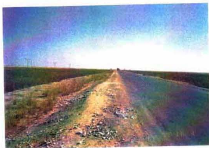
同上の道路、電力等インフラ状況
