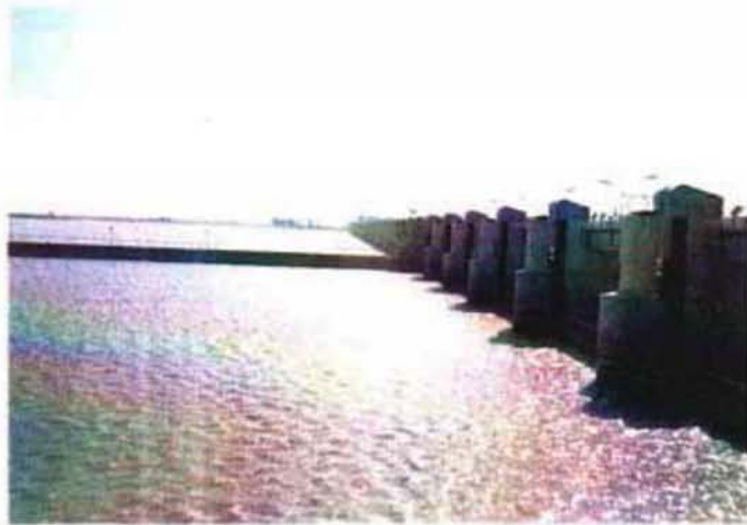
インダス川 Guddu Barrage 全景(上流側) 60 feet span×65 gates
