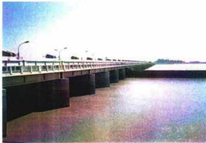
インダス川 Guddu Barrage 全景(下流側右岸堤)
