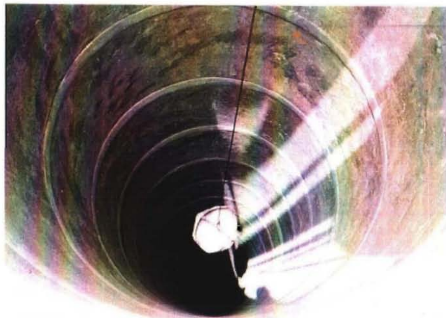
TRAVAUX DES PUIITS
