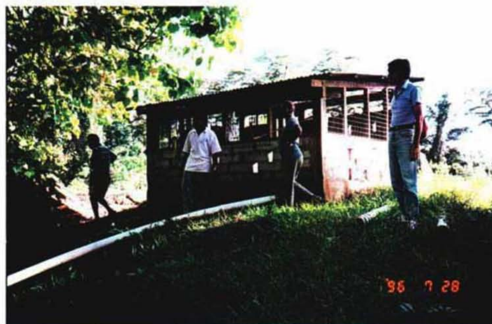
マライタ島Fiu地区 揚水機場
