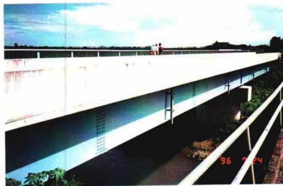
ガダルカナル平原中央部 Metapona川、橋梁架設 (1994年11月、日本の無償 援助による)
