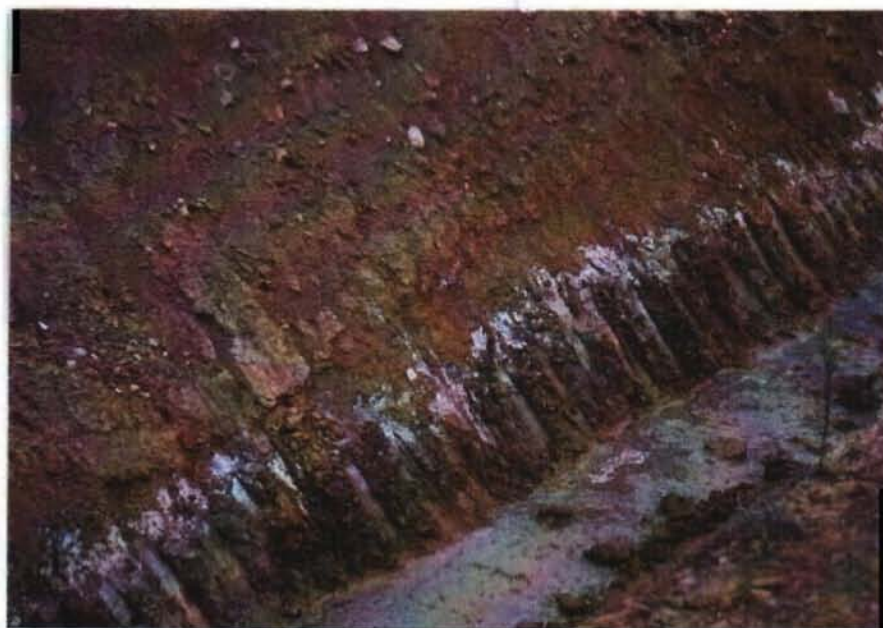
塩害対策の排水路の法面に塩類が集積している。このあと、暗渠パイプが埋設される。
