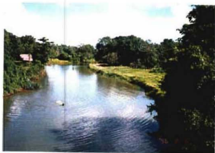
Dandugam Oya (アタナガル・オヤ下流放水口)
