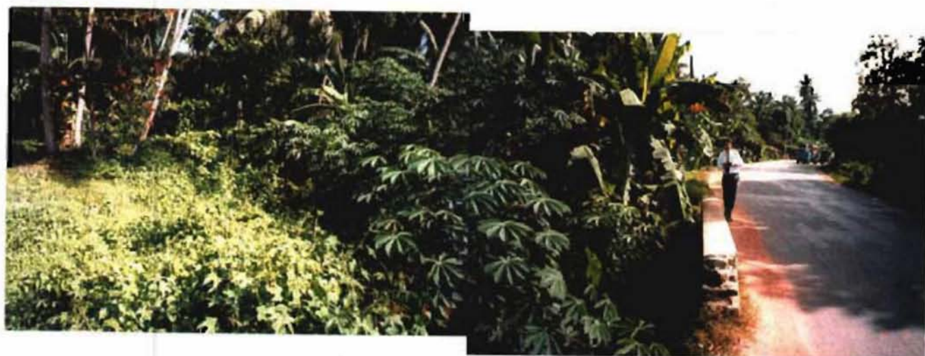
Kalu Ela (アタナガル・オヤ下流ショートカット水路左岸 現在堆砂等により機能していない)
