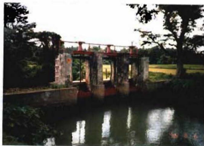
地区内サブ頭首工
