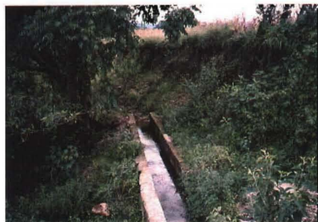
既存灌漑用水路
