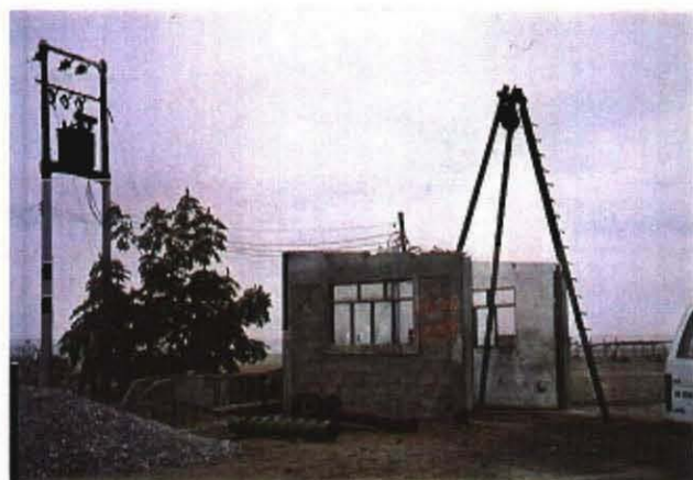
ポンプ交換作業中の井戸（ラ・ヤラダ地区）
