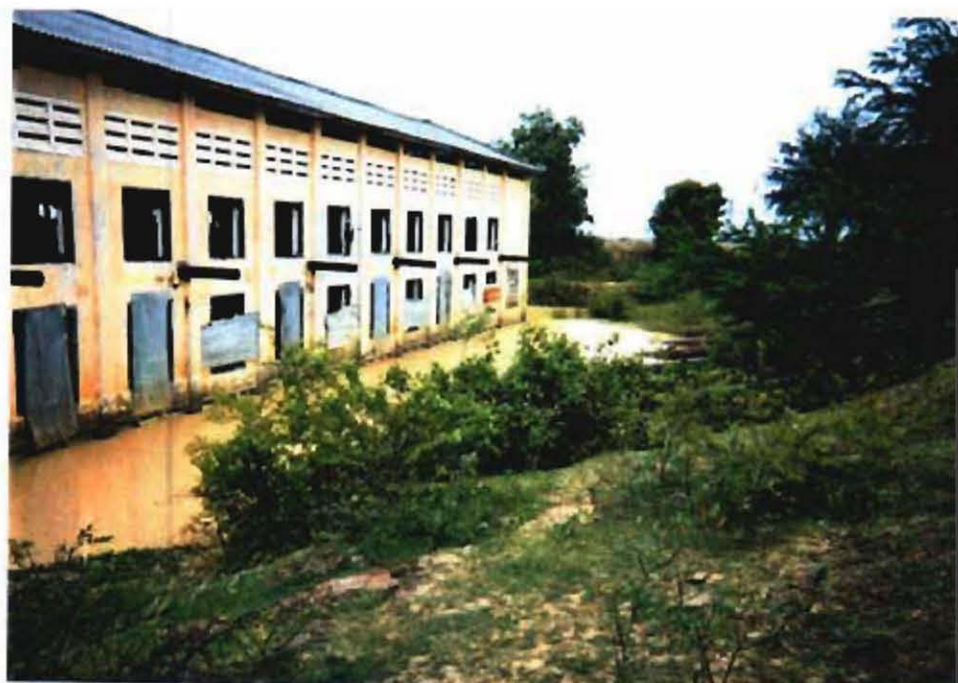
ポルポト時代1977年に 建設されたポンプ場。 (口径600mm×6台)
