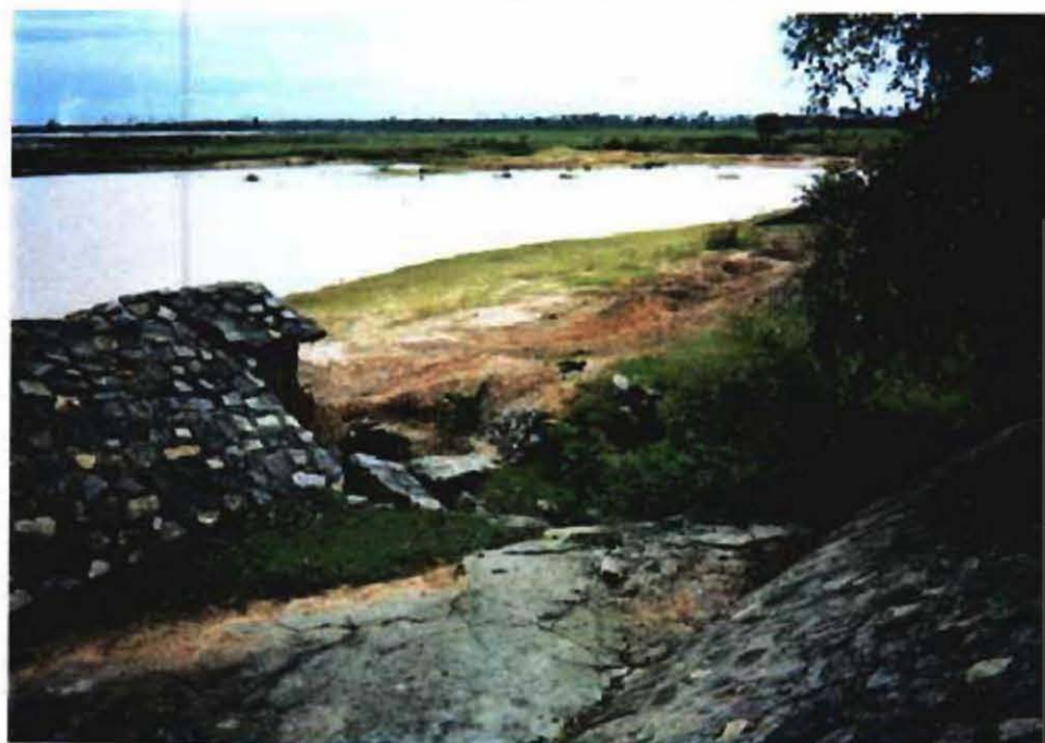
崩壊した土水路と受益 地。
