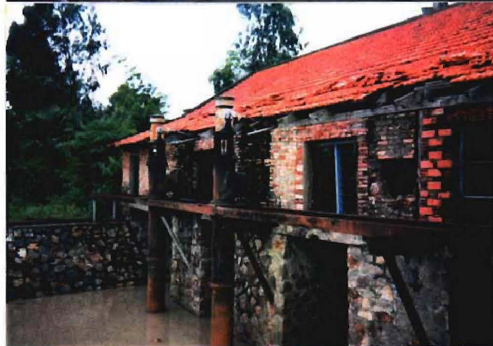
ポルポト時代のポンプ場 (現在機能していない)。
