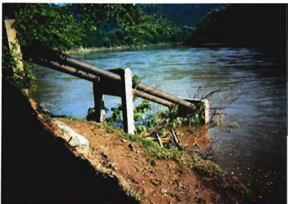
既存のポンプ灌漑取水 地点。(施設は破損して いて機能していない。)
