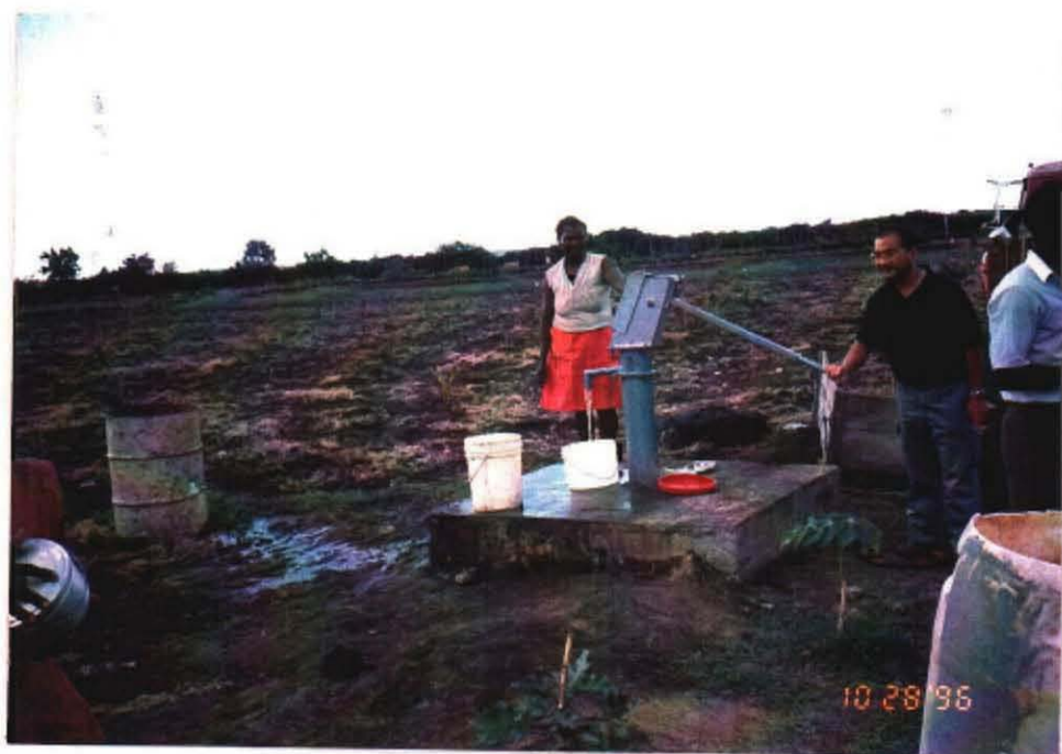
同 上に掘られているハンドポンプ井戸 ポンプの深度は約12m
