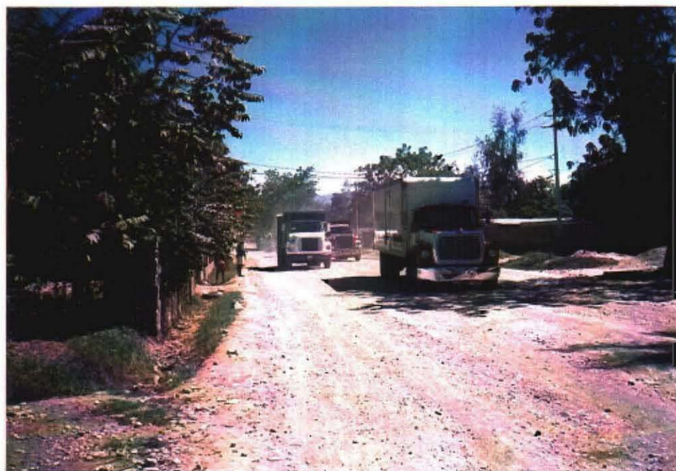
クワテブケーポルトランス間の国道 交通量が多く未舗装のため埃がおびただしい
