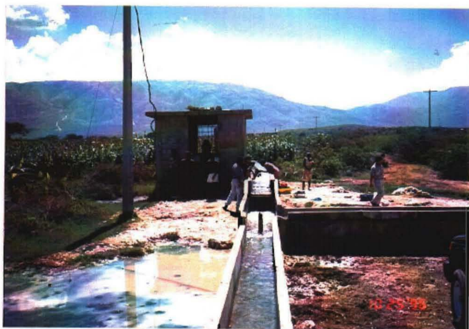
IDB 援助によって建設された地下水灌漑システム (クワデアク地区グランジュ川流域)
