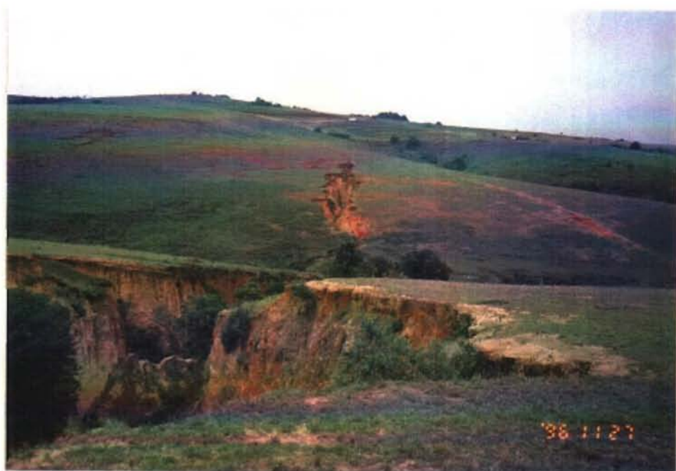
調査対象地域のガリ侵食（1）
