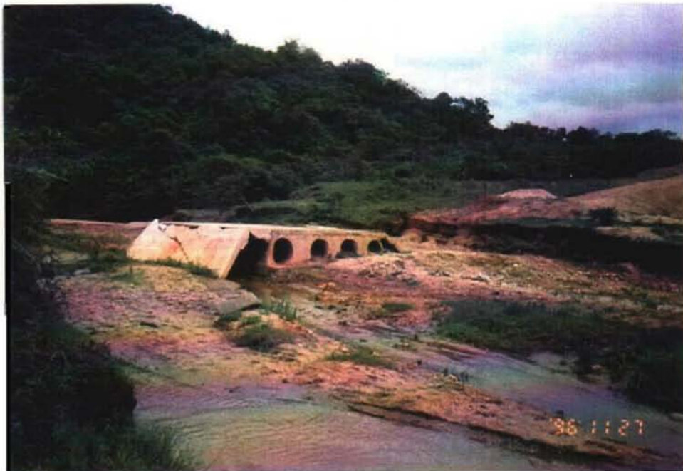
崩壊した橋梁
