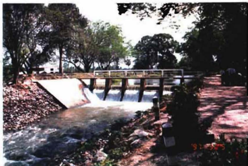
Na Thawi 取水堰
