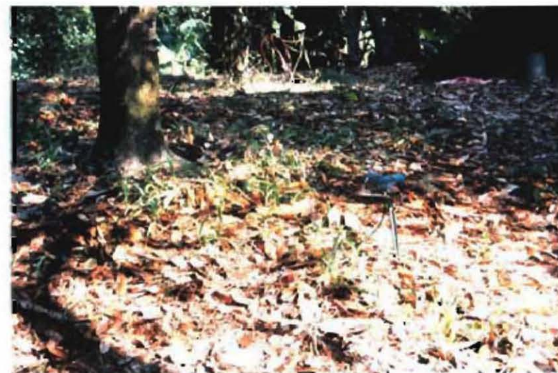
簡易スプリンクラー施設
