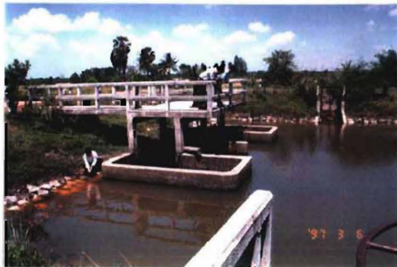
下流域の分水堰 河川をせき止めて両岸取水を行っている。
