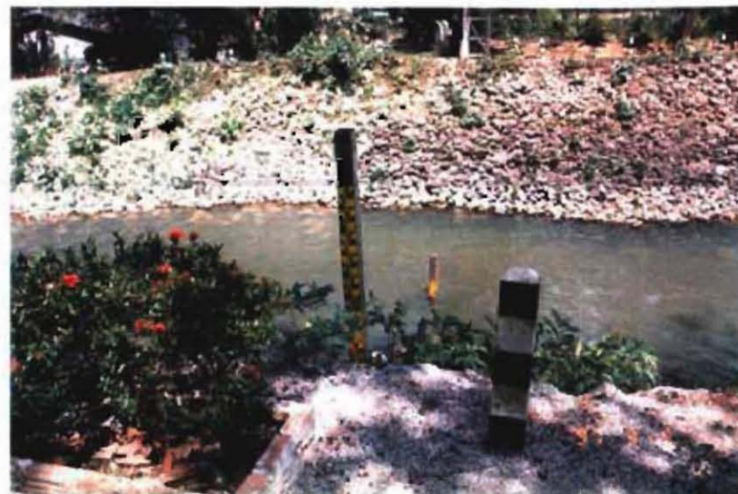
Na Thawi 取水堰付近の水位標
