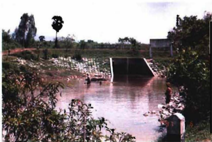
下流域の分水堰 河川をせき止めて取水している。
