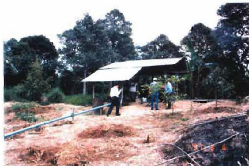
ポンプ取水施設
