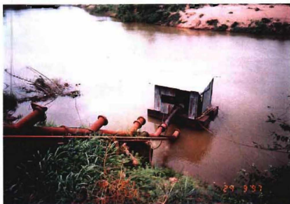
Krai Nun San ポンプ灌漑地区 Chi 川に設置されたフローティング・ポンプ
