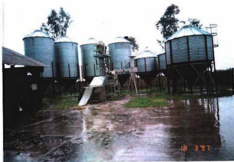
ノウシェラ穀類試験場 小麦・メイズの貯蔵施設(乾燥・送風施設は無い)
