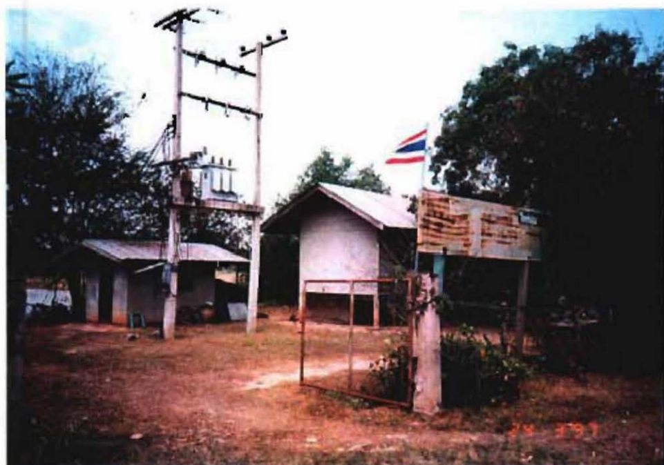
Krai Nun San ポンプ灌漑地区 70-テック・ポンプに電力を供給するための受電施設
