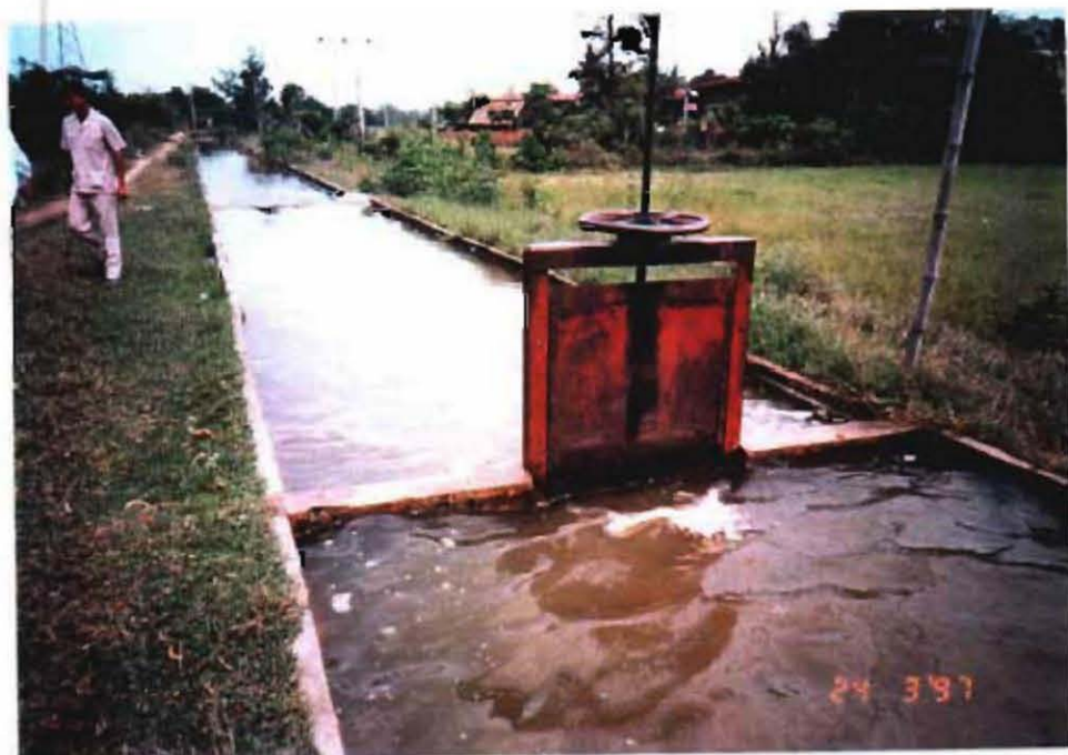
Krai Nun San ポンプ灌漑地区 幹線水路(ポンプ容量と水路容量が不一致)
