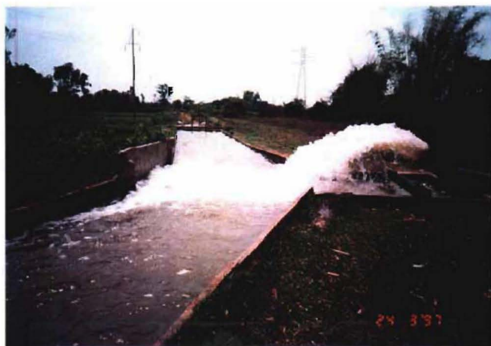
Krai Nun San ポンプ灌漑地区 70-テック・ポンプからの吐水部分と幹線
