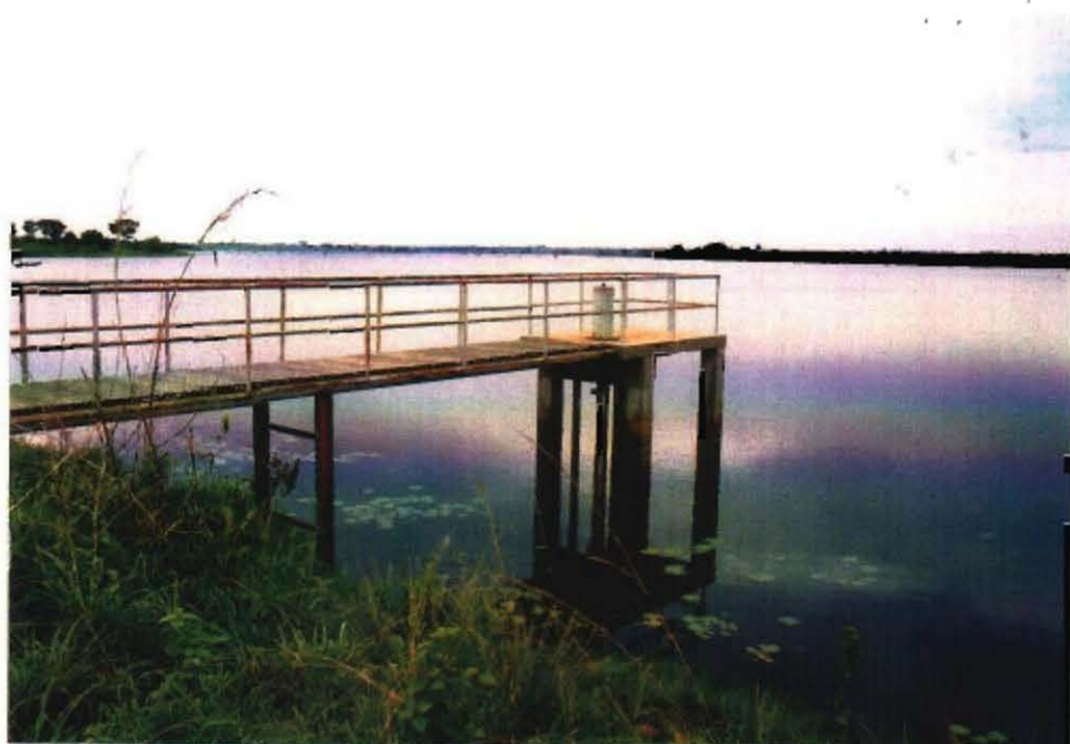
Koubi 地区の「象」国建設による中規模ダム。貯水池よりのポンプ灌漑によりパイナップル等のスプリンクラー灌漑を計画していたが、利用度が著しく低い。
