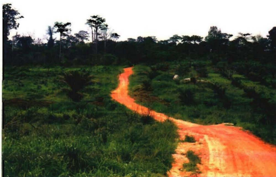
地方道の状況は劣悪であり、農村開発にあたっては、農道整備も重要なコンポーネントとなる。
