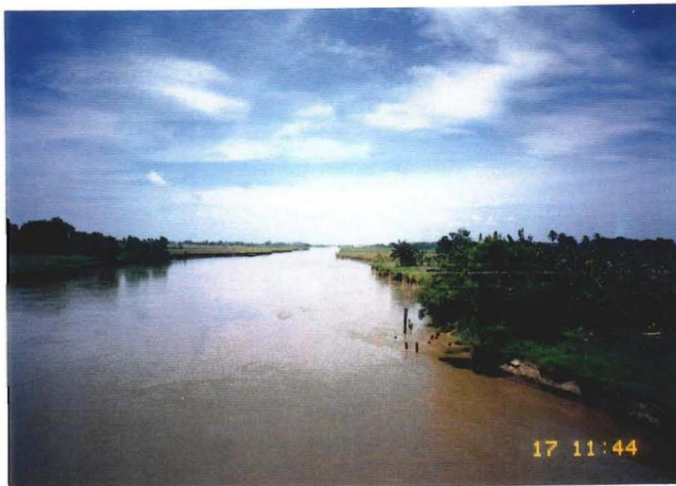
北部からリグアサン・マーシュに流入するプランギ川のバイパス水路。パガルンガン郡近辺ではプランギ川は蛇行し、しばしば周辺村落を湛水してきた。本バイパス完成後は浸水被害が軽減された。（下流方向）
