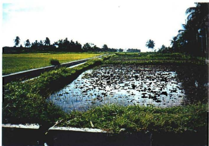
カ工地区灌漑施設状況
