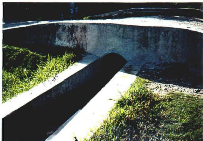
カ工地区灌漑施設状況
