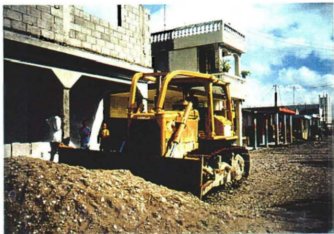
供与された建設機械（カエ地区）
