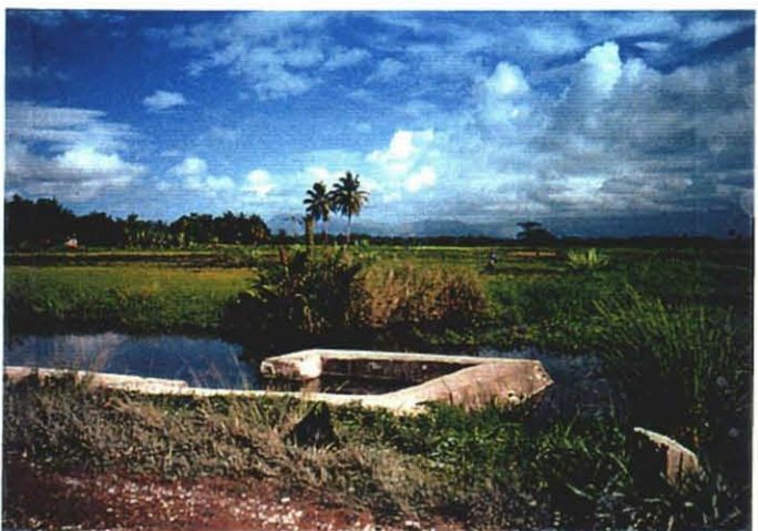
カ工地区灌漑施設状況
