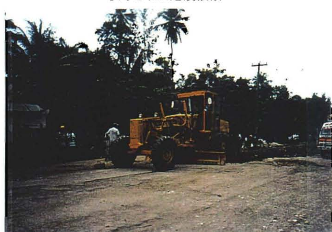
供与された建設機械
