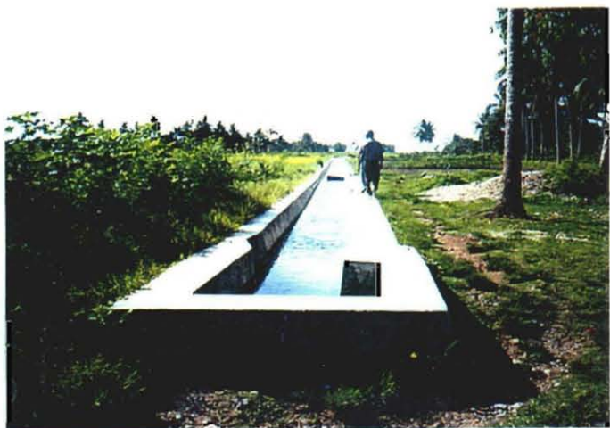
カ工地区灌漑施設状況
