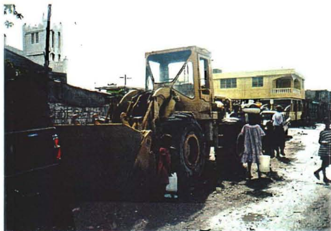
供与された建設機械（カエ地区）
