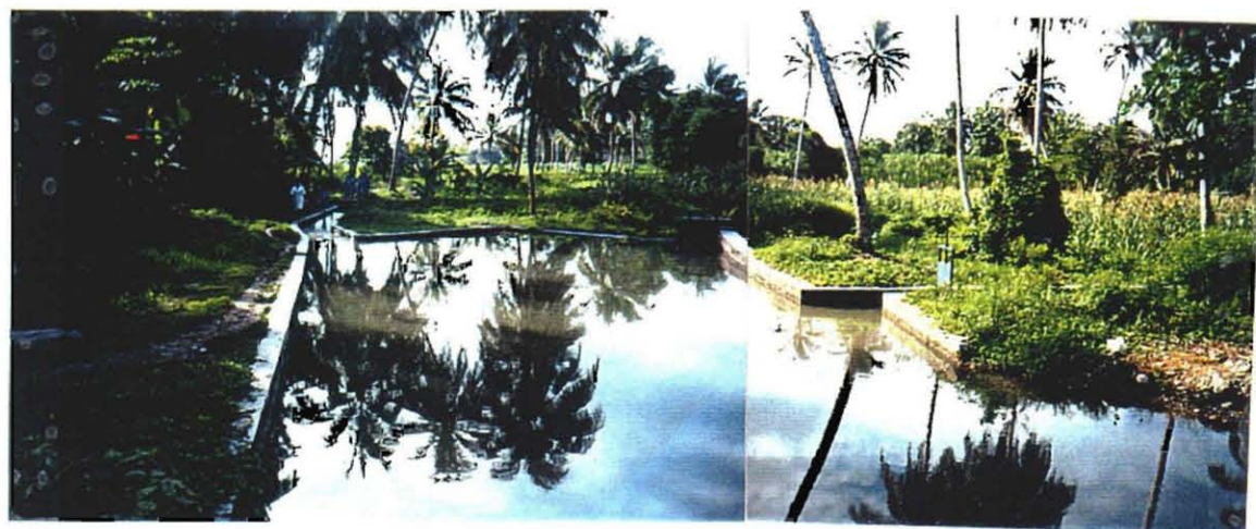
カ工地区灌漑施設状況
