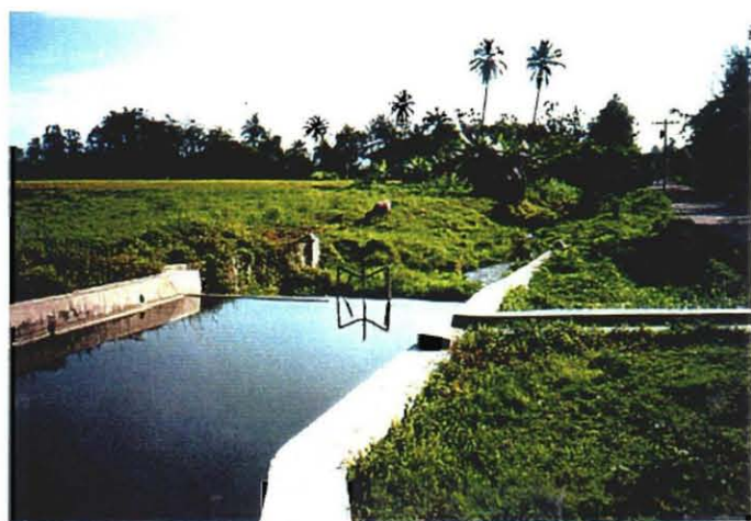
カ工地区灌漑施設状況
