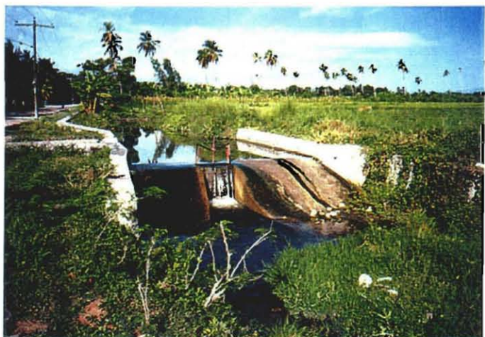
カ工地区灌漑施設状況
