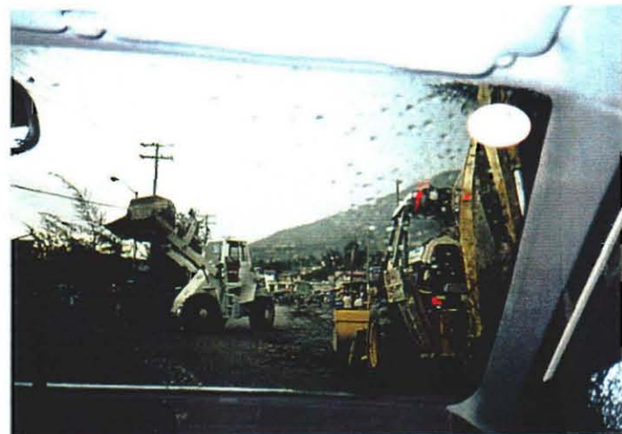
供与された建設機械
