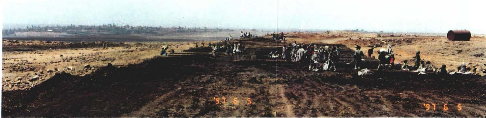
SAERTの監理によるダム施行（Maideleダム）、堤体の盛土作業を人力で施行している
