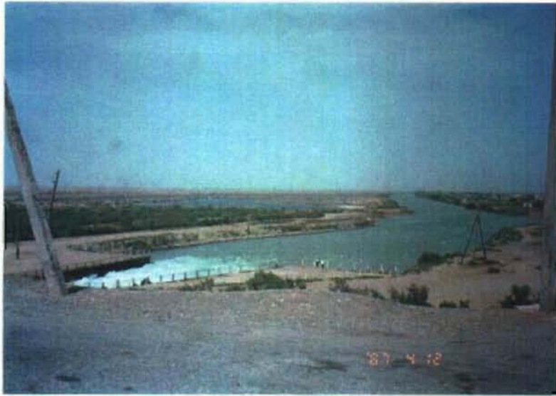
カラコム運河主水路 (Hanhowuz 調整湖付近)
