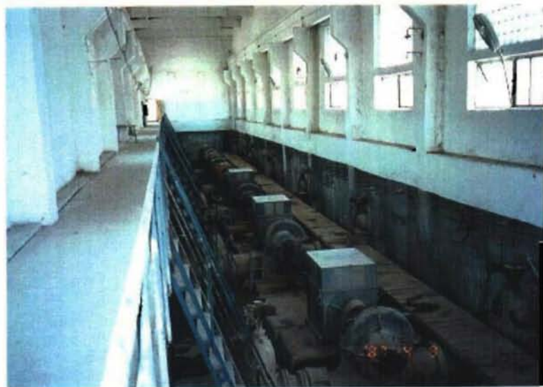
21号ポンプステーション ポンプ棟内部
