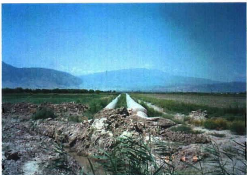
21号ポンプステーションから の配水用パイプライン
