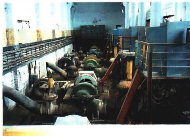
7号ポンプステーション ポンプ棟内部
