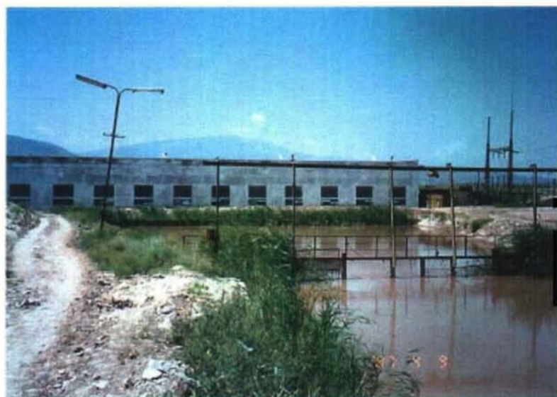
21号ポンプステーション ポンプ棟
