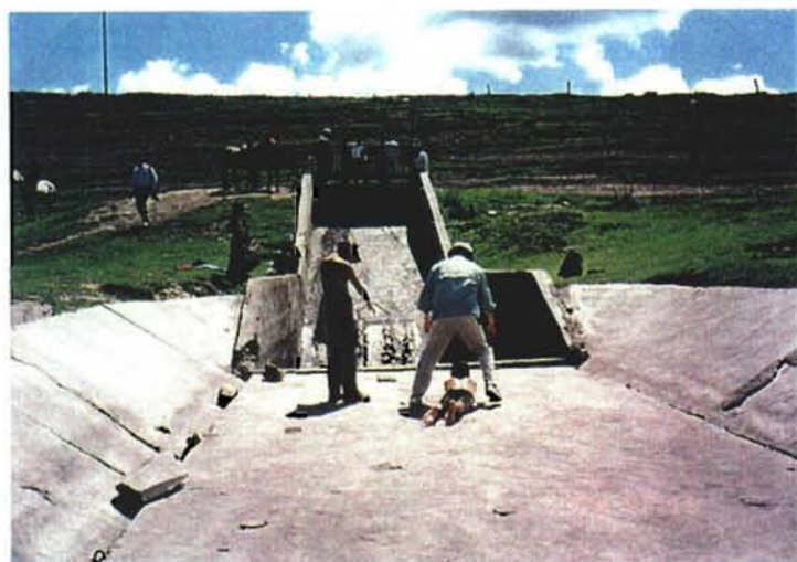
Jargalant 既存余水吐施設
