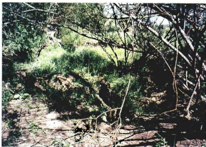
Sognogor 崩壊した上流幹線水路
