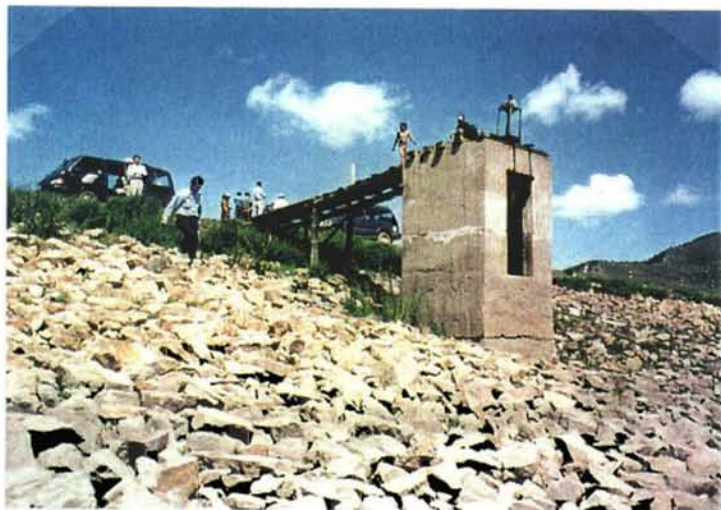
Jargalant 既存ダックビル式取水塔
