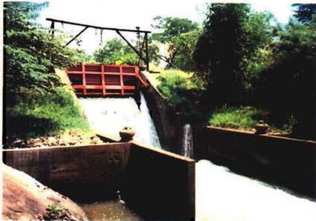
シギリムラ落差工
