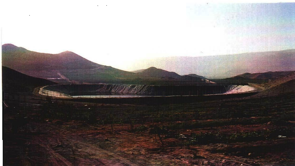
山腹の峠に設置された ウォータープール
