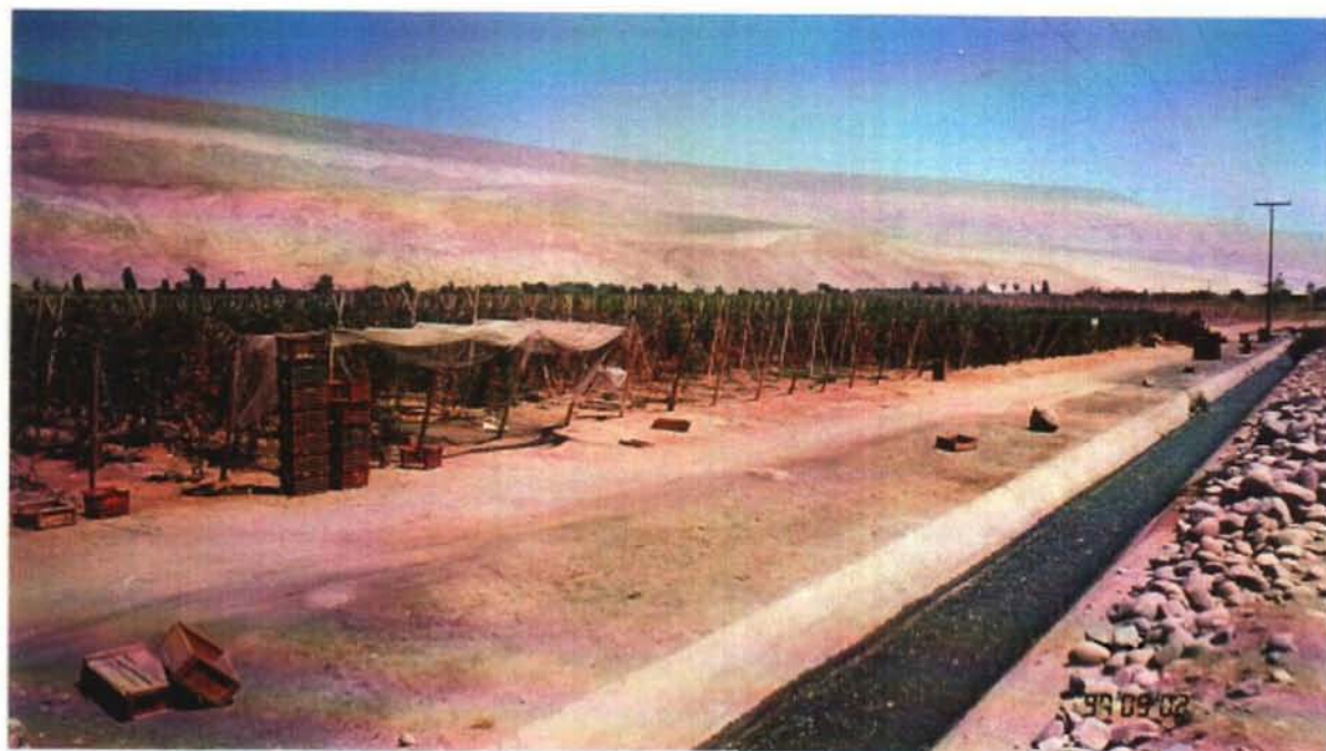
道路沿線を走る幹線用水路（サンホセ川左岸）
